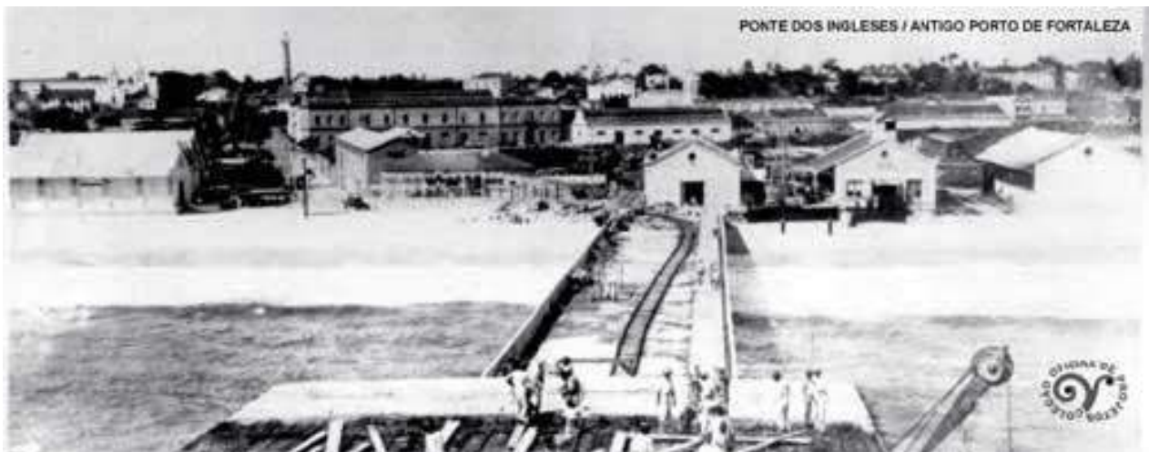
→ Ponte do Ingleses - Antigo Porto de Fortaleza.
