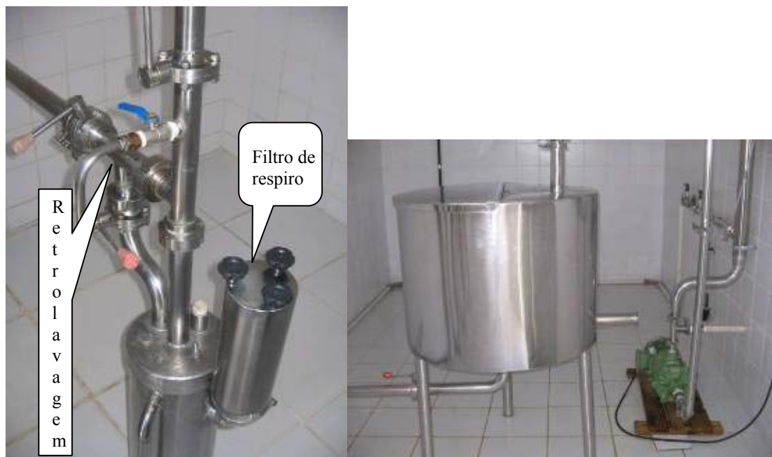
Foto 25 – Cabeça de poço – Parte interna da casa de captação – Mineradora Límpida Fonte: Autora, 2007
