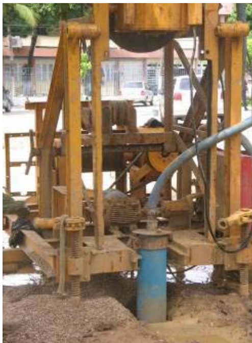
Foto 39 – Visita a perfuração de um poço – Reitoria – UFC (Fortaleza-CE) Fonte: Autora, 2008
