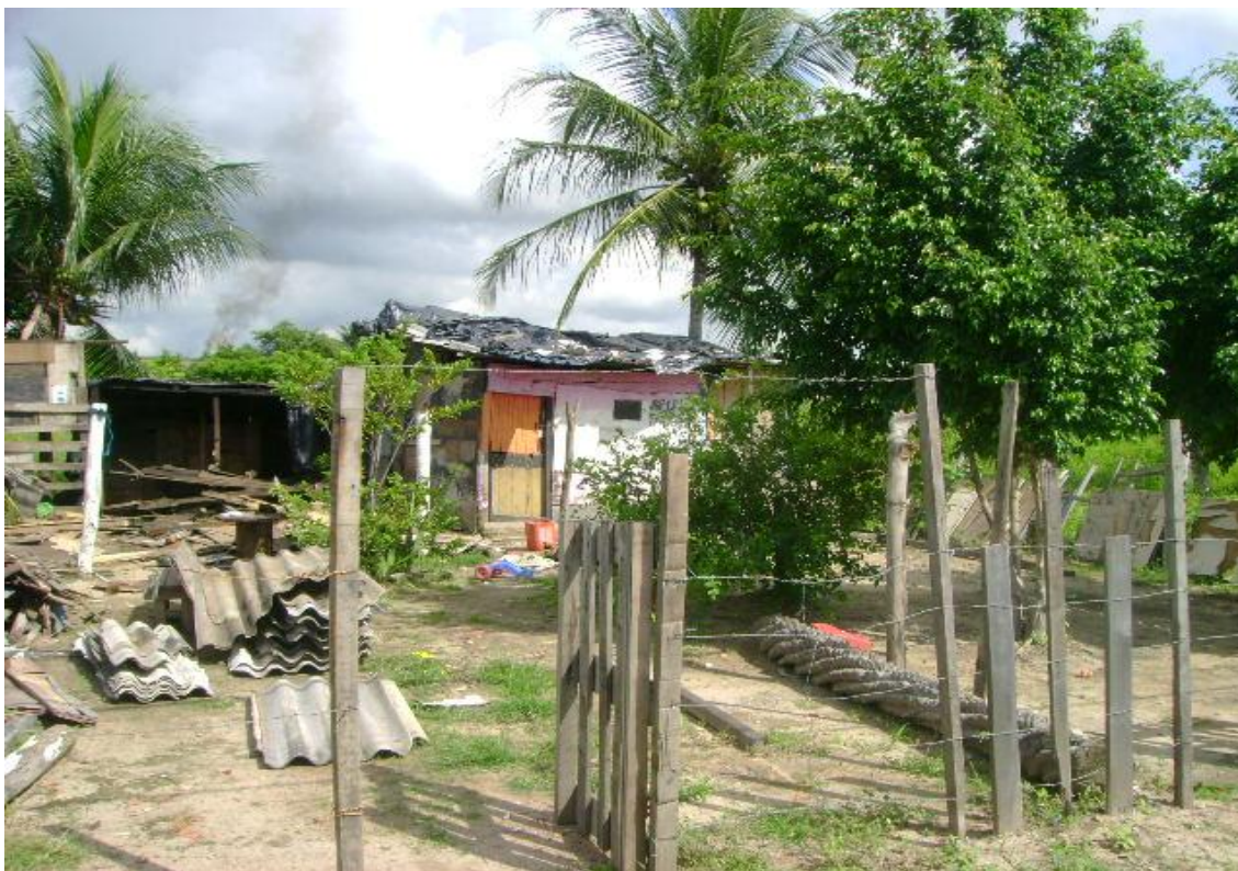
Casa na Favela Concretex, em 2008
