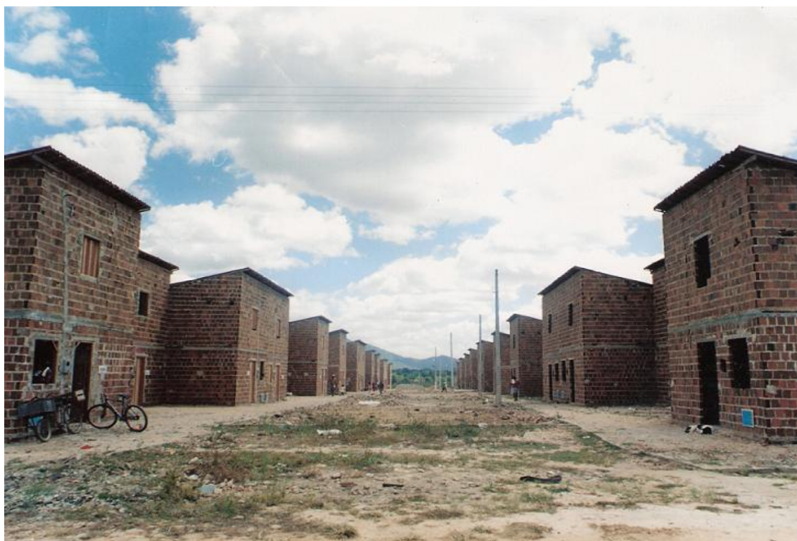
Obras do Mutirão Vida Nova – bairro Alto da Mangueira, em 1998
