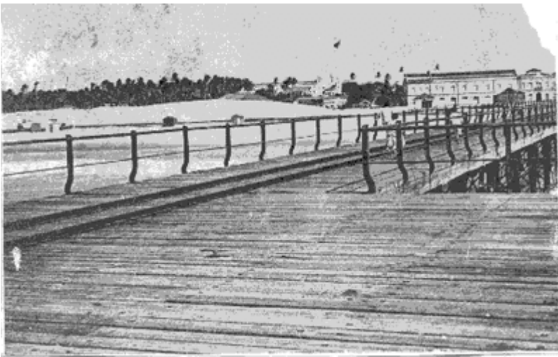
Figura 3. Ponte Metálica concluída em 1906, em fotografia, presumivelmente, de 1912 (Arquivo Nirez).
