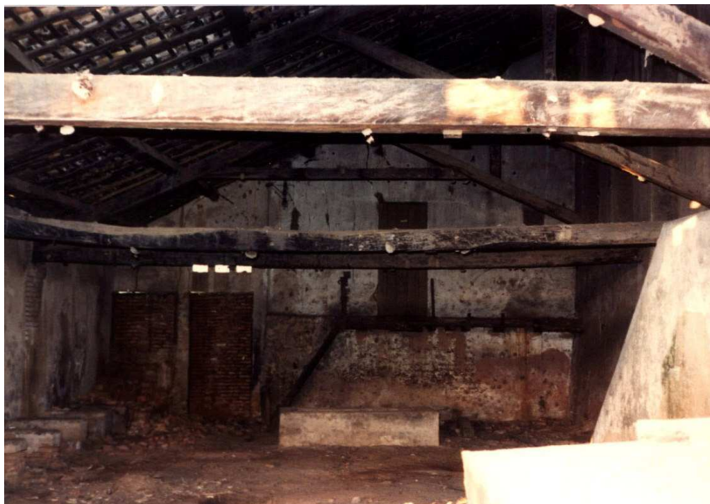
Foto 16 – Salão da fornalha visto em seu abandono, no início dos anos 1990. Observa-se ao fundo, num nível mais alto, a porta do escritório do patrão: “ e ele abria a porta e tava lá, a casa de fornalha e os caldeiros tudo mexendo ”.... Fotografia: Yacê Carleial.
