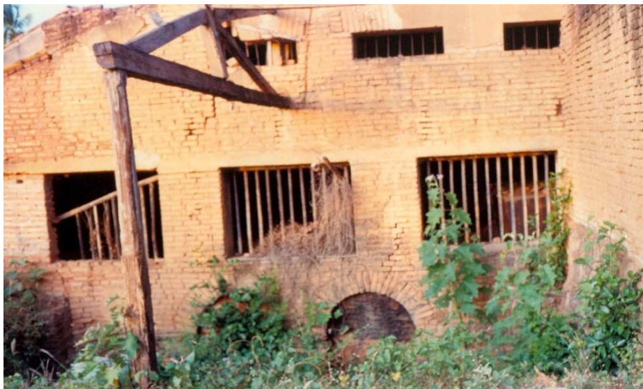
Foto 22. Vista externa (oeste) da sala da fornalha do Tupinambá , antes do desmoronamento nos anos 1990. Observa-se na parte inferior as duas “bocas de fogo” Fotografia: Yacê Carleial.
