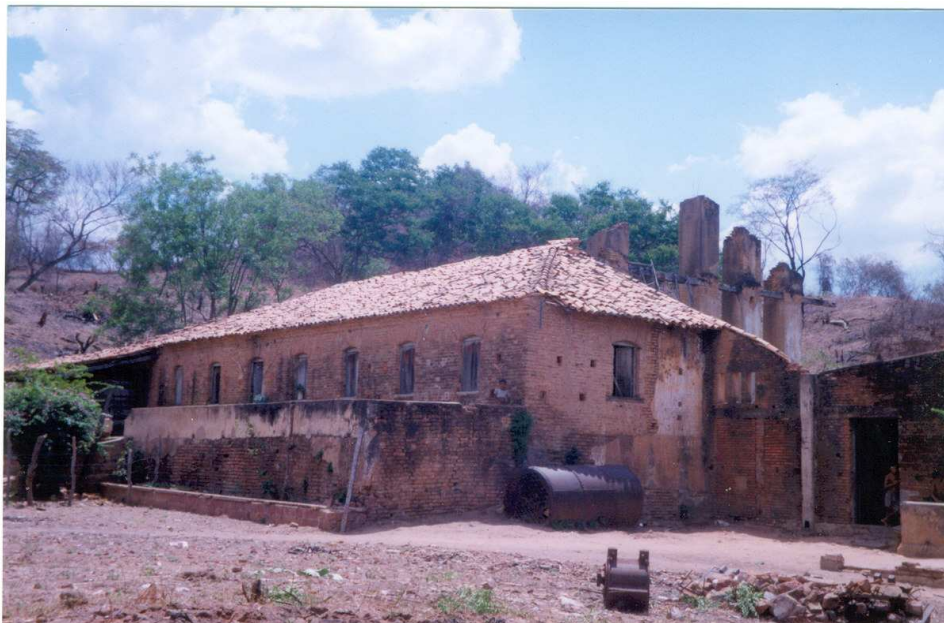
Foto 27 – Ruínas do Tupinambá em 2001. A parte que corresponde à Casa Grande resistindo temporariamente ao desabamento do engenho, na mesma estrutura. (É interessante fazer uma comparação com a Foto 17) Fotografia: Yacê Carleial.
