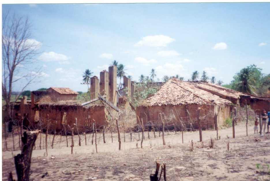
Foto 26 – Ruínas do Tupinambá em 2001. Engenho. Desabamentos posteriores fizeram desaparecer boa parte dos pilares ao centro e da cobertura à direita. Foto: Yacê Carleial.
