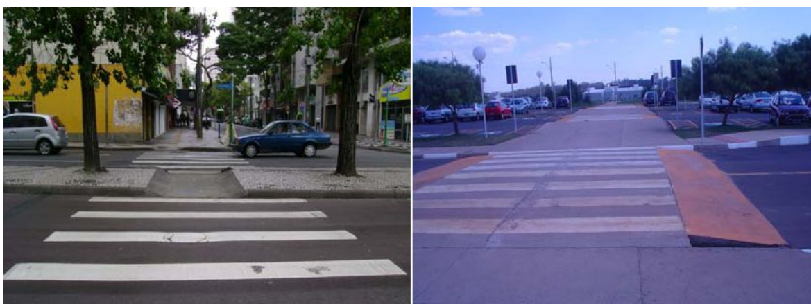
Figura IV-3.6: Exemplos de travessia com rebaixamento de calçada e travessia com faixa elevada, respectivamente.
