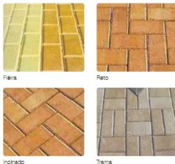
Figura IV-3.28: Estilos de assentamento dos pavimentos intertravados.
