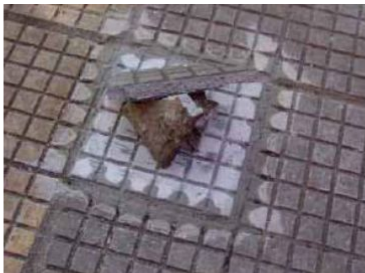
Figura IV-3.39: Ladrilho hidráulico em manutenção.
