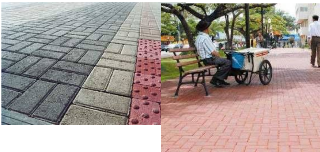
Figura IV-3.22 e IV-3.23 – Exemplos de calçadas com pavimentação corretamente instalada. Fonte: ABCP, 2010.
