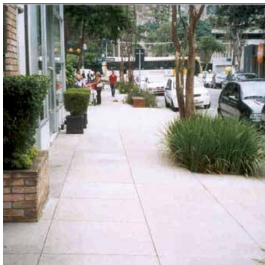
Figura IV-3.29: Calçada pavimentada com placas de concreto pré moldadas.
