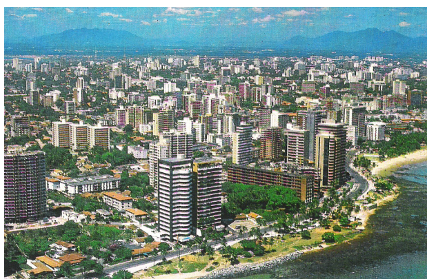
Figura II.7.1 - Crescimento dos edifícios ao longo da orla marítima, fim da década de 1980.
