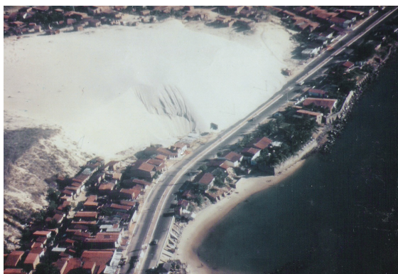
Figura II.2.8 – Avanço dunar sobre ocupações irregulares na Barra do Ceará, em 1997.
