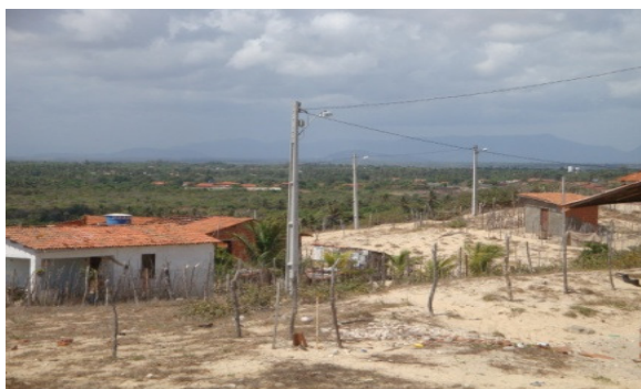
Figura 11-Foto – a presença de energia elétrica garante o mínimo de infraestrutura para o lugar.
