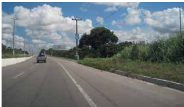
Fig. 3.96 Trecho 3 – rodovia CE 040
