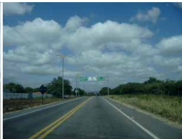
Fig. 3.69 Trecho 4 – via Estruturante
