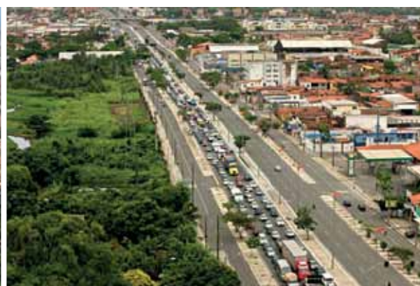
Fig. 3.59 Trecho 1 - av. Mister Hull
