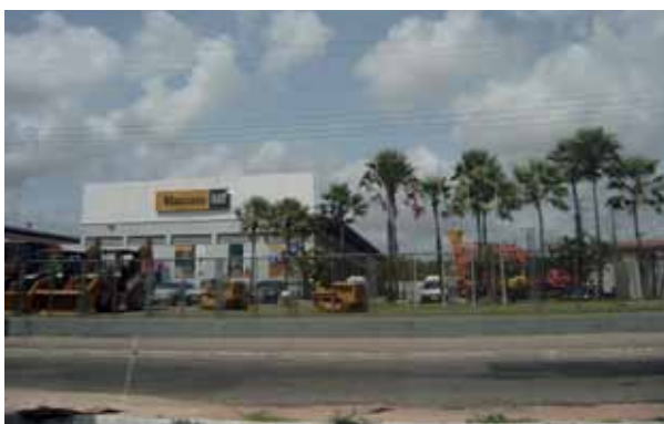
Fig. 3.38 Trecho 1 - início BR 116
