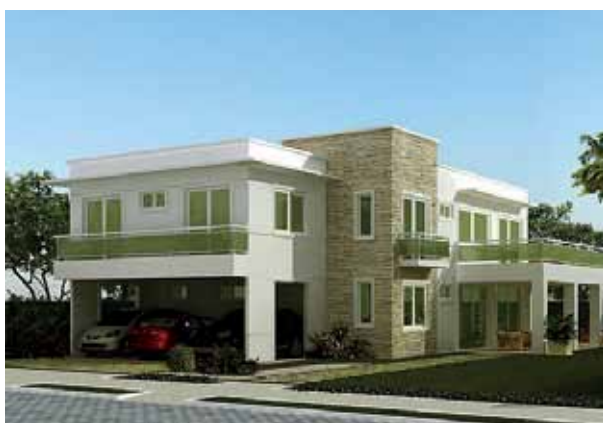
Fig. 3.90 Casa condomínio Quintas do Lago
