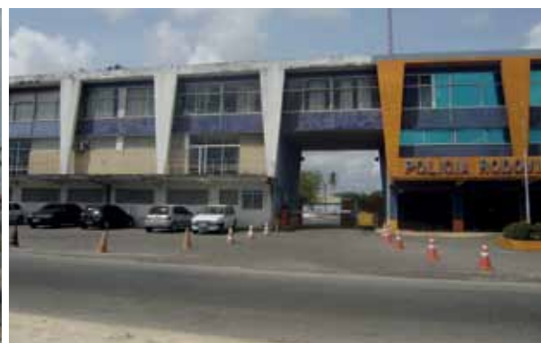
Fig. 3.39 Trecho 1 - início BR 116
