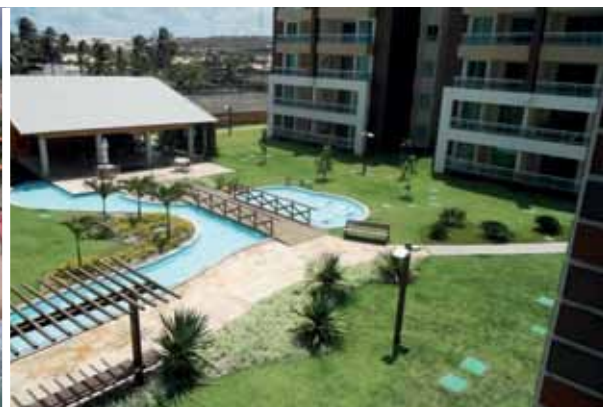
Fig. 3.102 Condomínio/ Porto das Dunas
