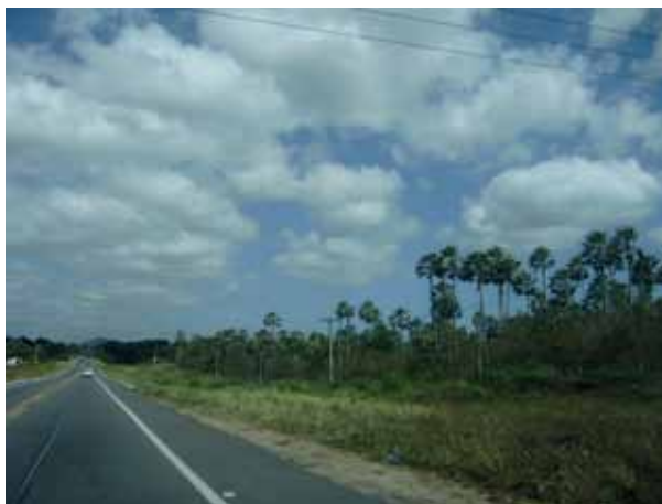
Fig. 3.68 Trecho 4 – via Estruturante
