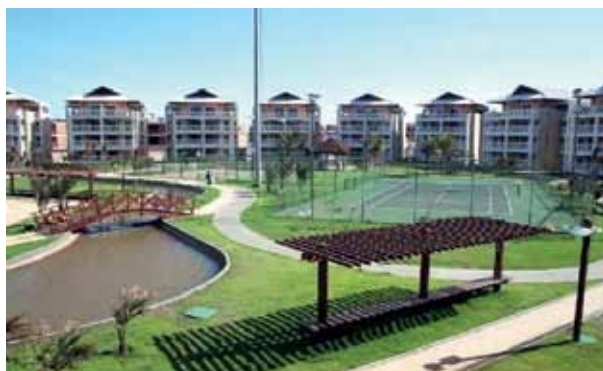
Fig. 3.103 Condomínio/ Porto das Dunas
