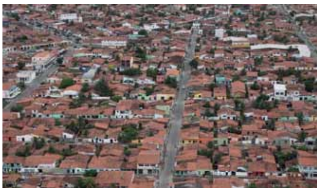
Fig. 2.20 Conjunto Habitacional no Município de Maracanaú
