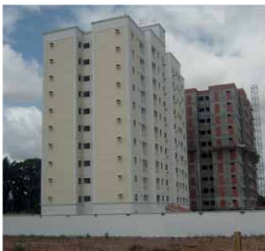
Fig. 3.20 Trecho 2 - Edifícios no bairro da Maraponga
