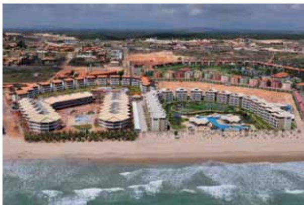
Fig. 3.101 Condomínio/ Porto das Dunas
