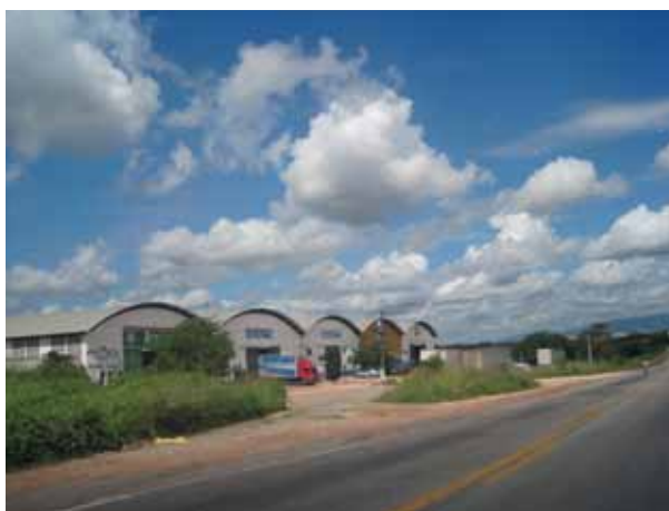
Fig. 3.118 4º Anel viário - armazéns
