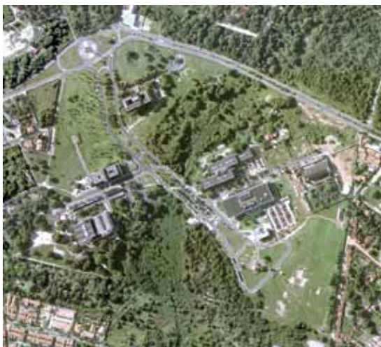
Centro Administrativo do Cambeba, 2001
