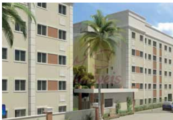
Fig. 3.18 Edifícios residenciais no bairro da Maraponga
