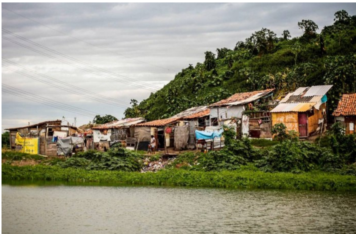
Figura 5 – Moradias irregulares na base do “morro” onde antes funcionava o aterro
