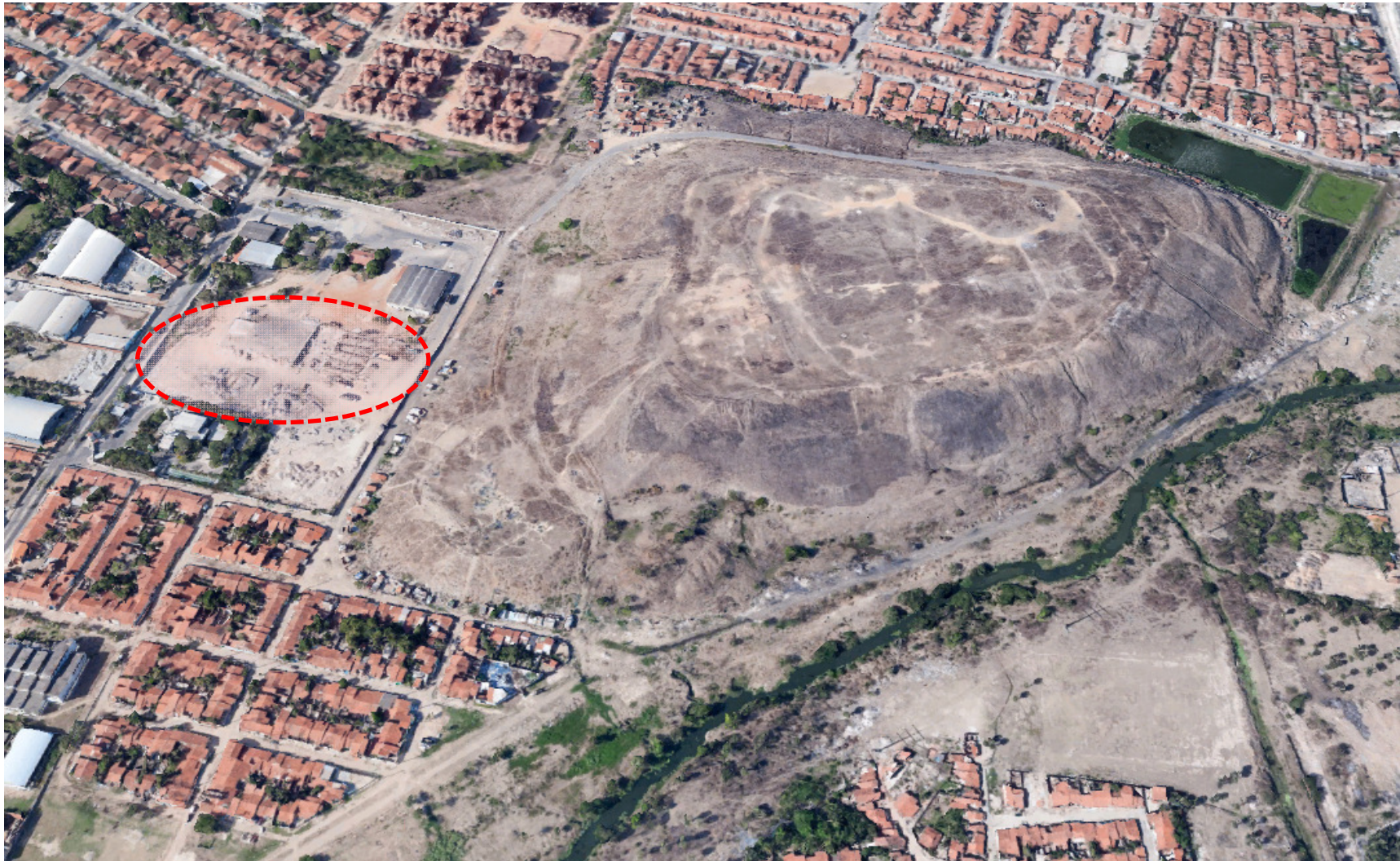
Figura 4 – Visada aérea aproximada com destaque para a área de transbordo
