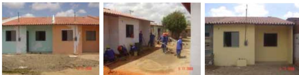
Figura 25, 26 e 27 – Urbanização da Favela Marrocos, com construção de novas unidades
