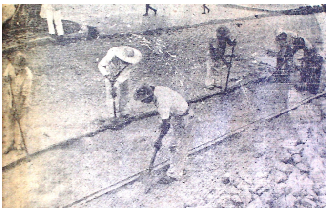
Retirada dos trilhos do bonde elétrico da linha do
