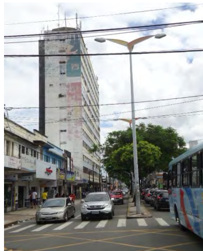
Figura 30 – Condomínio Ed. Jalcy ao fundo
