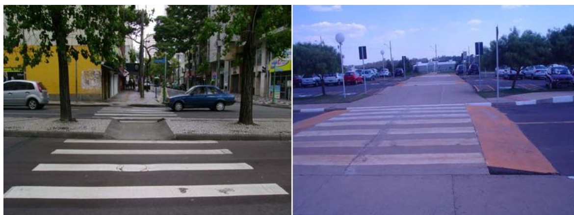
Figura IV-3.6: Exemplos de travessia com rebaixamento de calçada e travessia com faixa elevada, respectivamente.
