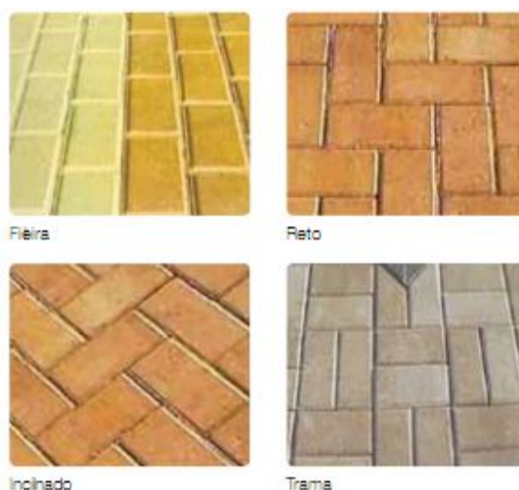
Figura IV-3.28: Estilos de assentamento dos pavimentos intertravados.
