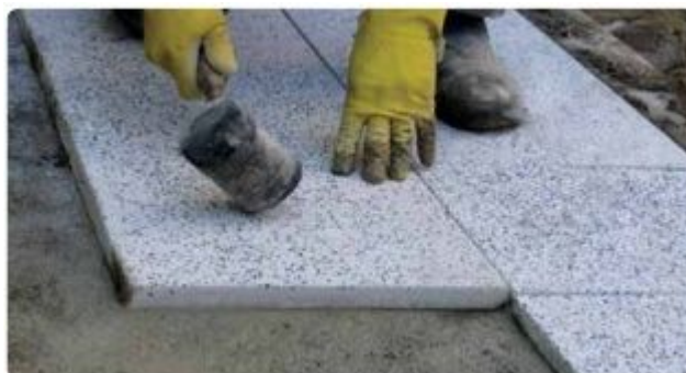
Figura IV-3.31: Placas assentadas sobre argamassa - sistema aderido.
