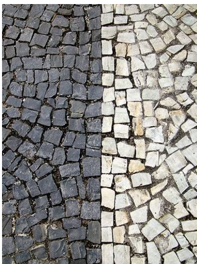
Figura IV-3.24: Pedra portuguesa com sua irregularidade de superfície. Fonte: ABCP, 2010.
