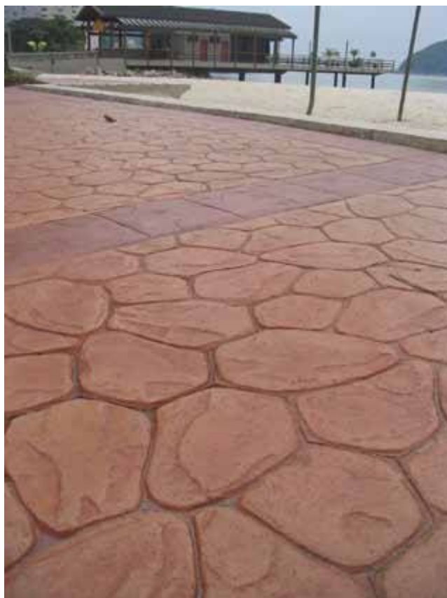
Figura IV-3.33 e IV-3.34: Casos de aplicação de concreto moldado in loco .
