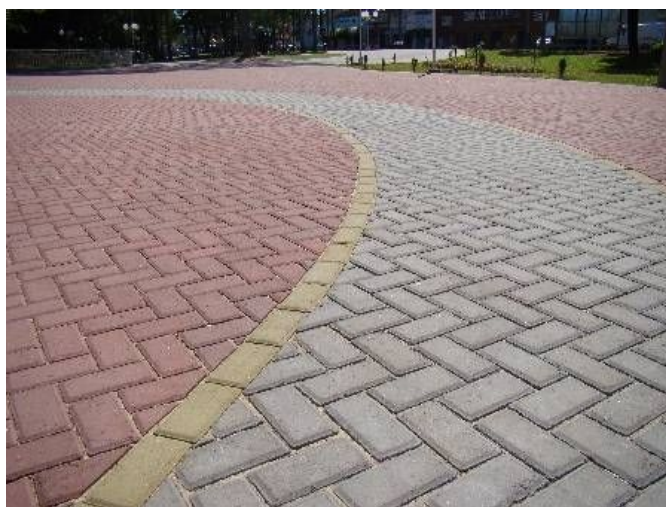
Figura IV-3.25: Pavimento intertravado em área urbana. Fonte: ABCP, 2010.
