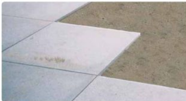
Figura IV-3.30: Placas assentadas em material granular - sistema flutuante.
