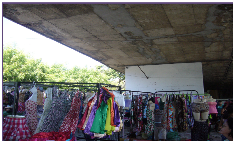
Figura 3: Estacionamento do Viaduto
