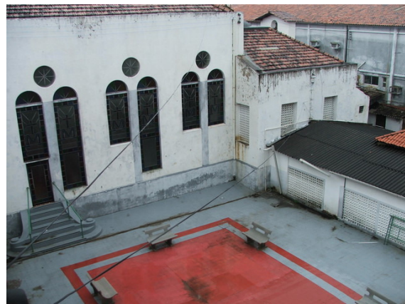
Vista fachada lateral da capela
