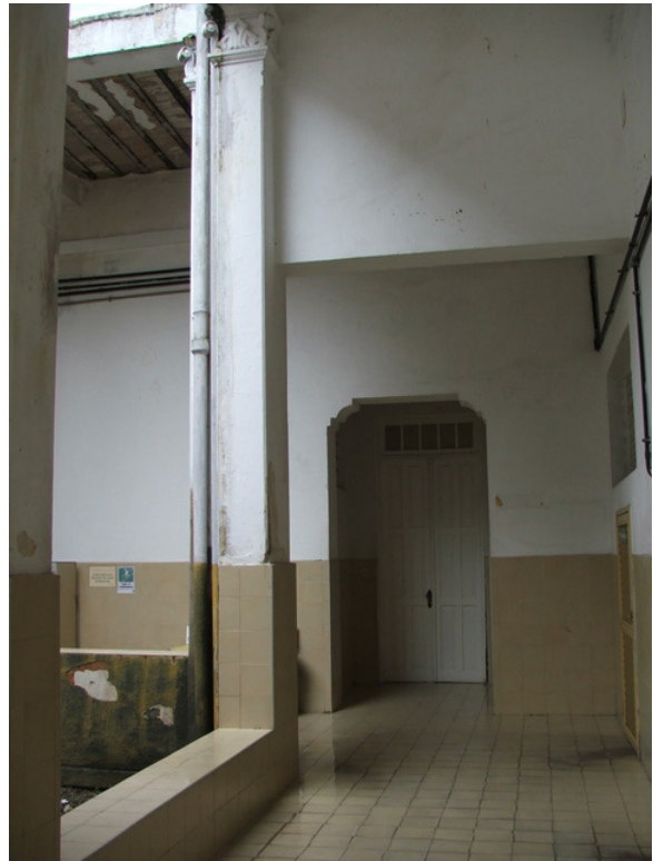
Vista acesso seção sul
