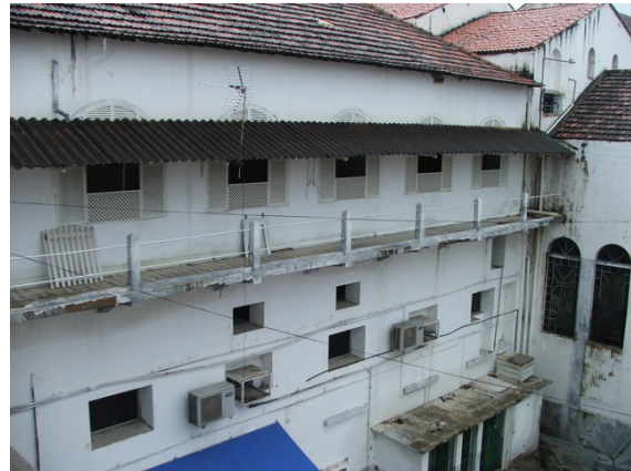
Vista fachada oeste (interior)
