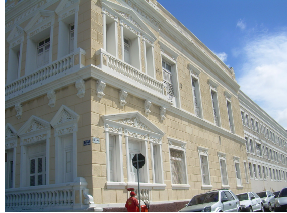
Vista fachada lateral norte (Rua Senador Jaguaribe)
