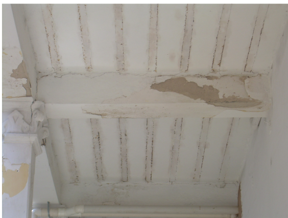
Vista laje (mista - tijolo e perfis metálicos)
