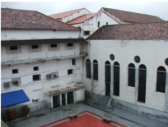
Vista fachada lateral da capela
