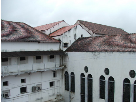
Vista coberta (telha cerâmica)
