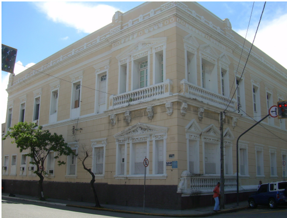
Vista fachada lateral sul (Rua Dr. João Moreira)
