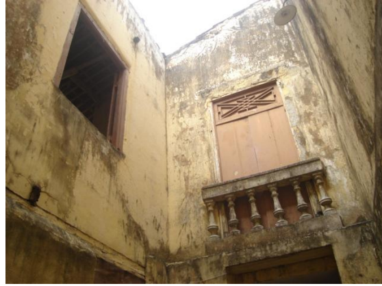
Vista do poço de ventilação e iluminação
