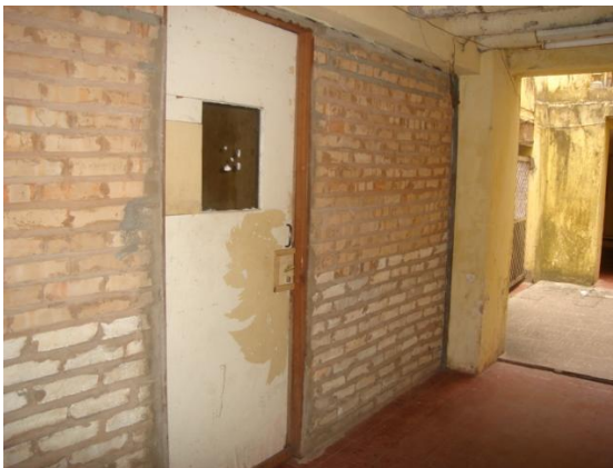
Parede de construção recente para sala acústica no porão alto e vista da circulação com destaque para o vigamento em carnaúba
