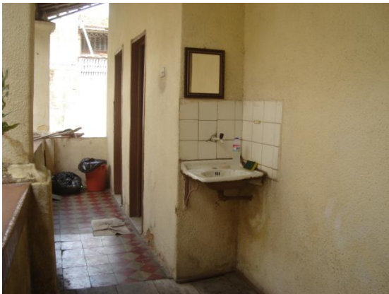
Vista externa dos banheiros
