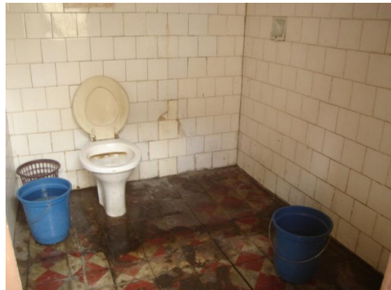
Vista interna do banheiro masculino
