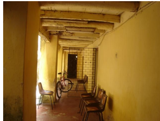
Parede de construção recente para sala acústica no porão alto e vista da circulação com destaque para o vigamento em carnaúba
