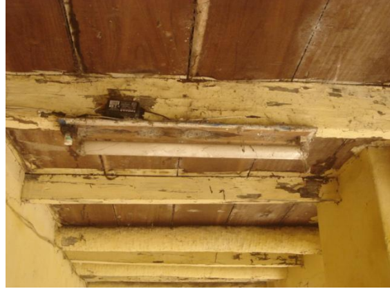
Detalhe do vigamento em carnaúba e aroeira do porão alto
