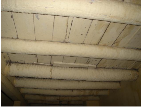
Detalhe do vigamento em carnaúba e aroeira do porão alto
