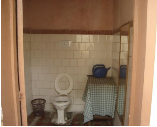
Vista interna do banheiro feminino
