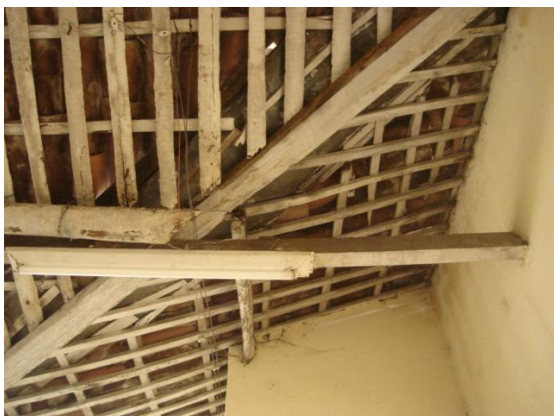
Madeiramento da cobertura da área de junção entre o volume principal e o "puxado"
