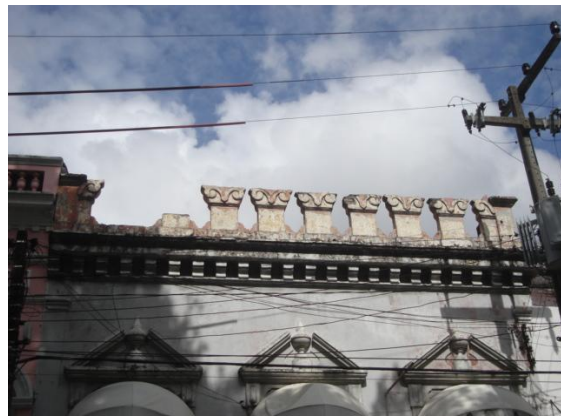
Vista da fachada marcada pelo poluição visual e privatização do passeio e detalhe da platibanda em ameias danificadas
