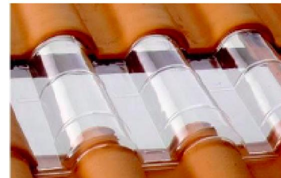
Figura 7 - Iluminação por inserção de telha translúcida
