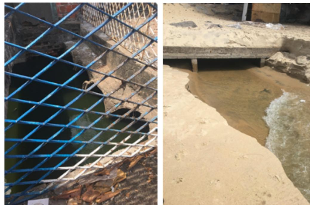
Figuras 13 e14 - Manilhas de concreto existente para o escoamento de água para o mar (esquerda), chegada das águas pluviais ao mar por meio de rede de drenagem da prefeitura.
