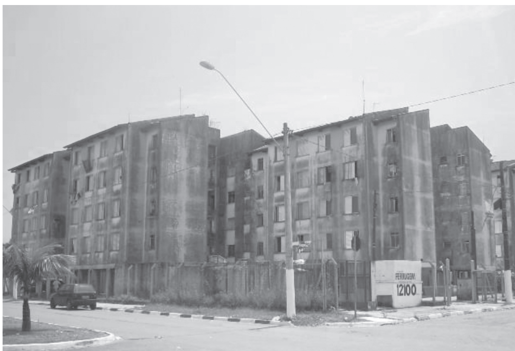
Foto 10: Conjunto Habitacional no município de São Vicente – Estado de São Paulo.
