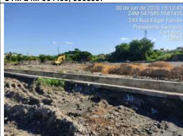
Foto 8 – Espalhamento de material (areia) no solo
