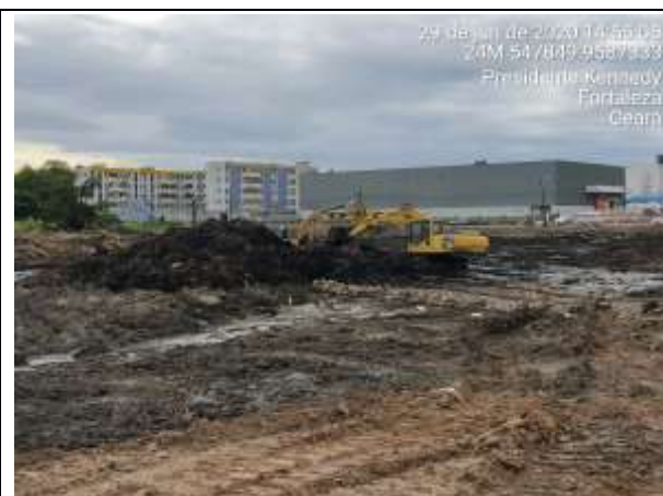
Foto 4 – retirada de solo (bota-fora)
