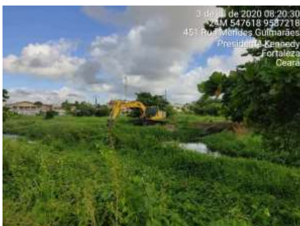
Foto 13 – Abertura de vala para escoamento
