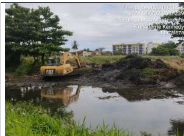
Foto 15 – retirada de vegetação marginal e limpeza do assoreamento do riacho.
