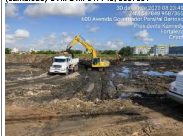
Foto 7 – Retirada de top soil .
