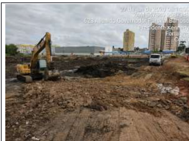
Foto 3 - retirada de solo (bota-fora)
