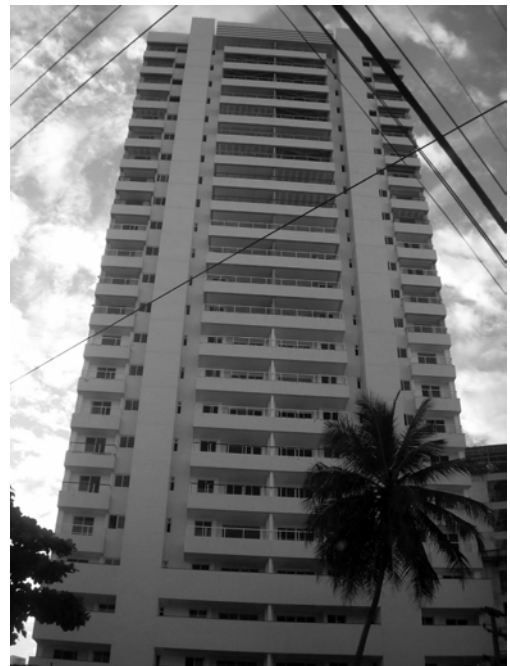
157. Edifício residencial ocupa, hoje, o lote da antiga residência à Av. Rua Mons. Catão.
