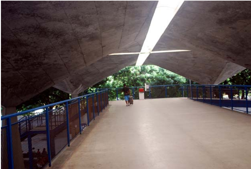
25. Luciano Marrocos Aragão. Terminal Rodov. João Thomé, 1969. Passarela de acesso às plataformas. Foto do autor.
