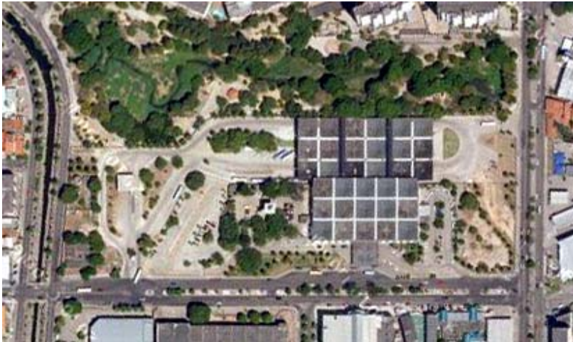
19. Luciano Marrocos Aragão. Terminal Rodov. João Thomé, 1969. Vista aérea. Fonte: Google Earth.
