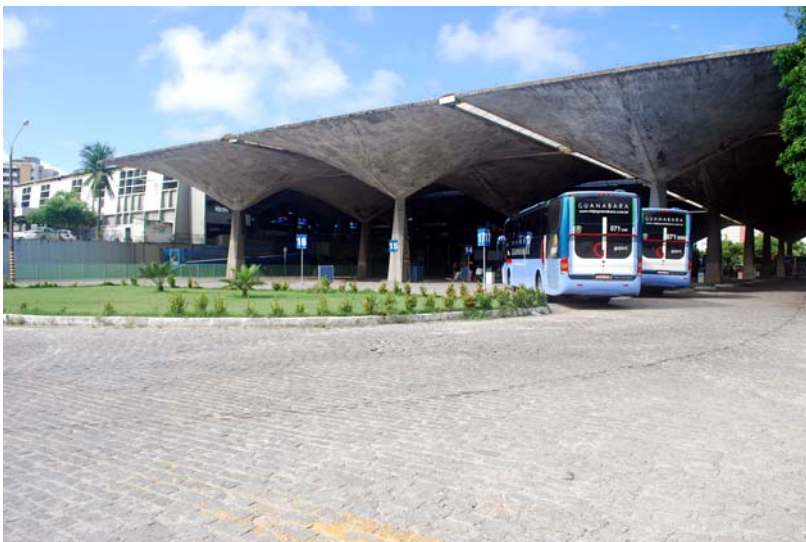
20. Luciano Marrocos Aragão. Terminal Rodov. João Thomé, 1969. Fachada sudoeste. Foto do autor.
