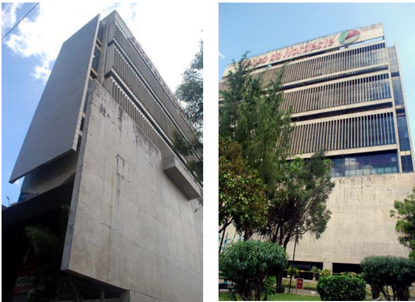
65-66. Nelson Serra e Neves, José Alberto de Almeida, Antônio Carlos Campelo e Carlos Alberto Farias Costa. Edifício Raul Barbosa, 1978. Fachadas oeste e sul. Fotos do autor.
