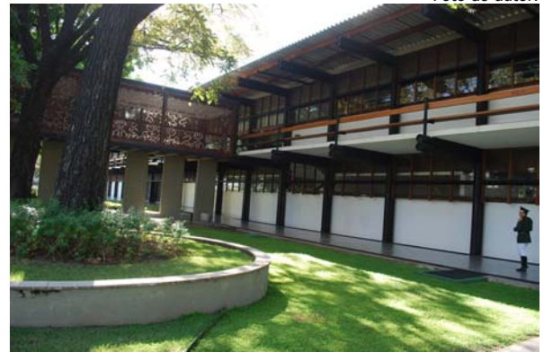
40. Sérgio Bernardes. Palácio da Abolição, 1970. Detalhe da passarela de ligação com o anexo. Foto do autor.
