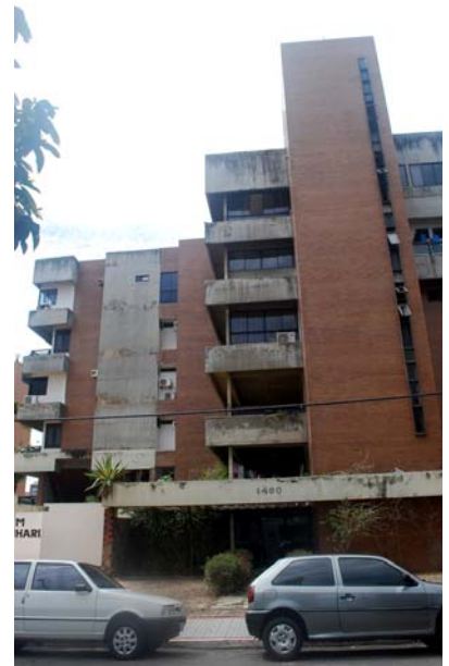
93-94. Regis Freire. Ed. Isaac Pontes, 1978. Fachadas oeste e norte. Fotos do autor.
