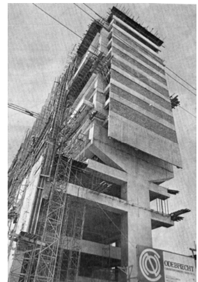
69. Nelson Serra e Neves, José Alberto de Almeida, Antônio Carlos Campelo e Carlos Alberto Farias Costa. Edifício Raul Barbosa, 1978. Fachada oeste (em obra). Fonte: Panorama [...] (1982), v.2.
