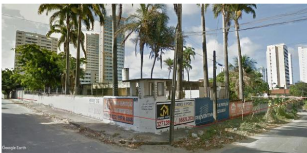
Figura 6.23. Localização 13: Construção existente e aparentemente abandonada na área destinada como praça no projeto de loteamento. 1
