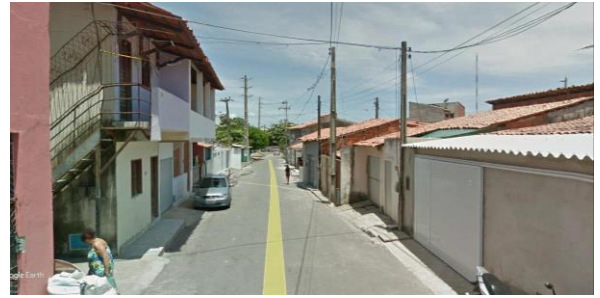
Figura 5.13. Localização 4: Ocupação irregular em leito de via pública por habitação precária. 1
