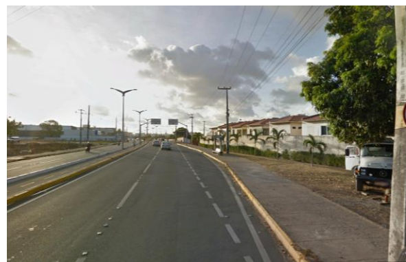
Figura 4.20. Localização 10: Av. Maestro Lisboa (CE-025), sentido oeste. 1
