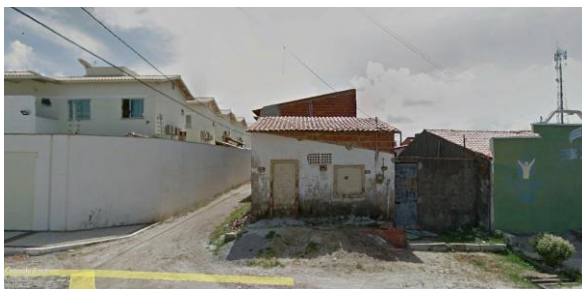
Figura 5.16. Localização 7: Via e área livre públicas do loteamento ocupadas por habitação precária, ao lado de condomínio residencial horizontal. 1
