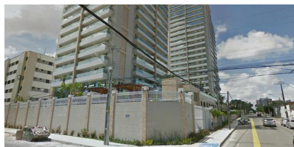
Figura 6.24. Localização 14: Condomínio residencial vertical. 1
