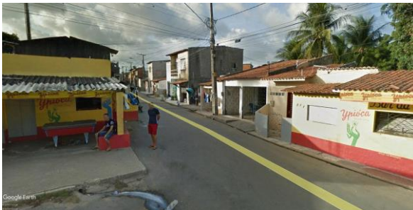
Figura 5.14. Localização 5: Ocupação irregular em leito de via pública por habitação precária. 1
