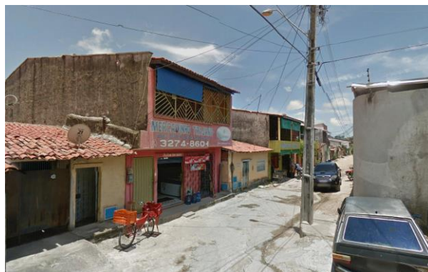
Figura 4.14. Localização 6: Ocupação não-conforme nas proximidades da Instituição Casa de José de Alencar, ocupando parte do leito de via. 1
