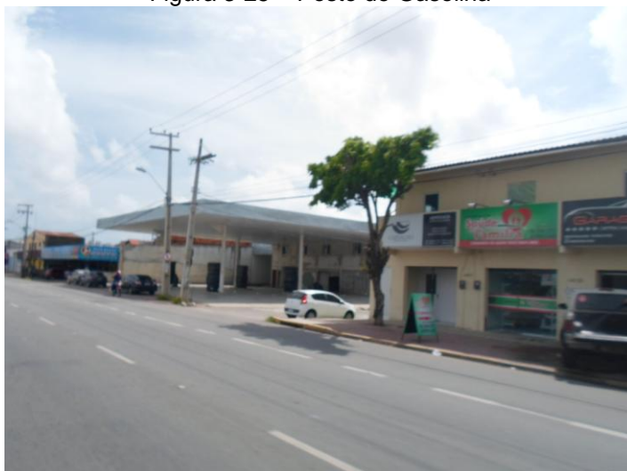
Figura 3-25 – Posto de Gasolina
