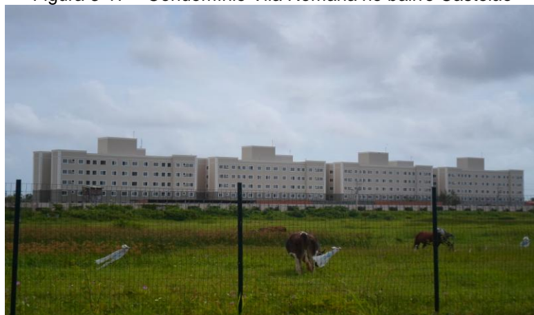
Figura 3-17 – Condomínio Vila Romana no bairro Castelão
