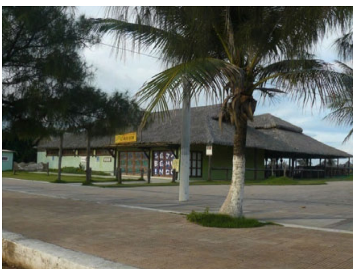
Figura 40. Barraca de Praia 2 Fonte: Emanuel Cavalcanti
