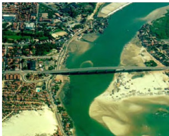
Figura 9. Ponte do Rio Ceará Fonte: Heron Félix
