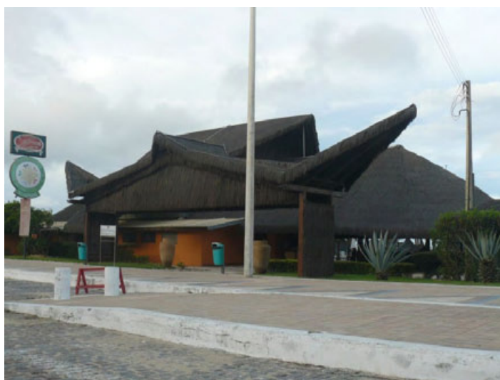
Figura 39. Barraca de Praia 1 Fonte: Emanuel Cavalcanti
