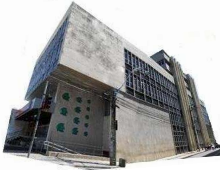
Figura 4 – A aparência modesta para sede de corporação tão importante quanto o BNB deve-se ao fato de o projeto original de vinte e dois pavimentos (incluindo subsolo e térreo) não ter sido construído.
