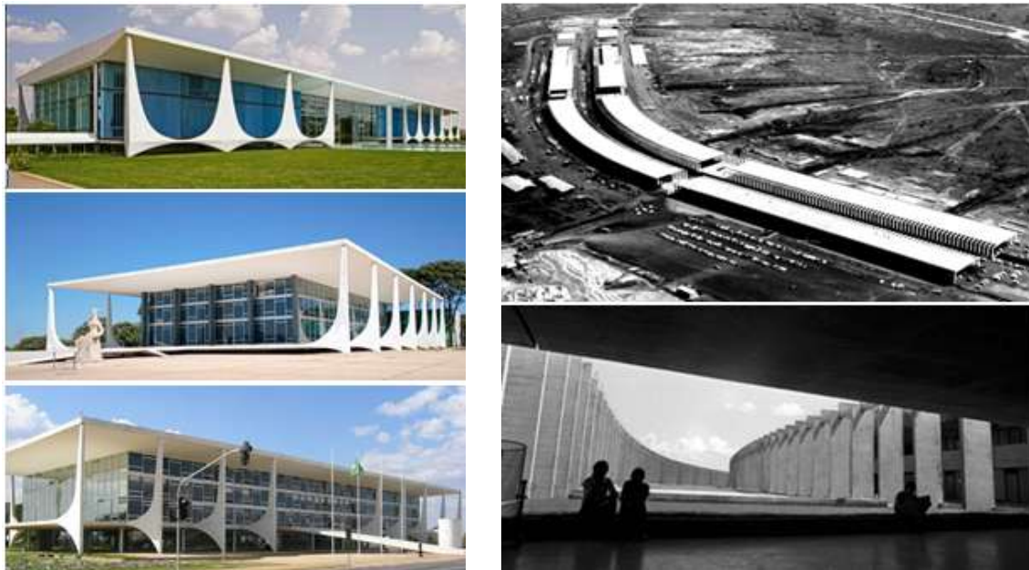
Fig. 9 – Nos palácios de Brasília (esq), o partido da caixa de vidro coberta por grande laje plana apoiada em colunas que são variações de um mesmo perfil, demonstra um desejo de simplificar, de obter alguma padronização. O Instituto Central de Ciências, com incríveis 720m, inaugura um novo patamar na proposição de espaços contínuos, de integração física e visual.
