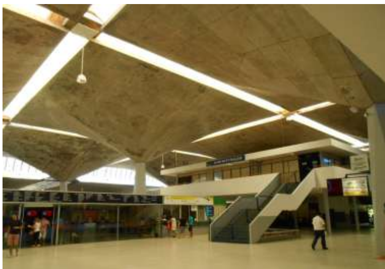
Figura 46 – No alto, uma vista da rodoviária no ano de sua inauguração, implantada em um entorno ainda pouco ocupado. A esquerda, vistas atuais do embarque/desembarque e área 'social'. A primeira sofreu alterações maiores com a inserção de rampas e passarelas; a segunda teve substituição de piso, acrílicos, iluminação e dos quiosques originais de concreto que podem ser vistos na foto mais antiga á direita. Fonte – www.blog.baratocoletivo.com.br (alto), fotos do autor (2014) (esq) e www.fortalezanobre.com.br (dir)
