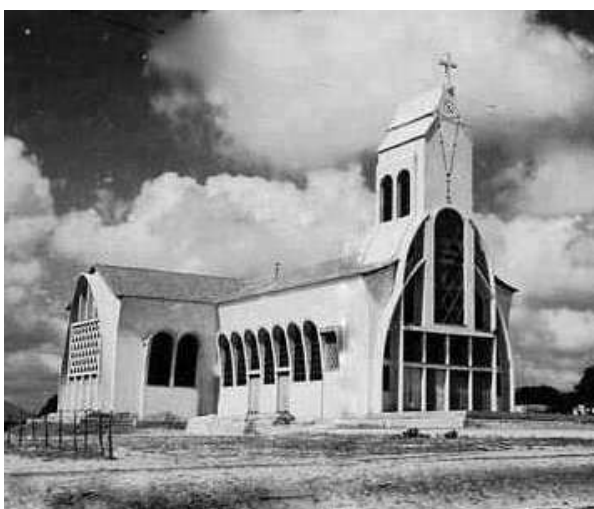
Figura 27 – Igreja de N. Sra. de Fátima, projeto de Luciano Pamplona, 1952-55. Uma construção exótica, na qual a estrutura moldada em concreto na forma de parábolas e paredes curvas se assemelha a rosa, símbolo de Maria. Neste santuário ainda em construção (dez de 1953), a santa estátua peregrina oriunda da Cova da Iria, Portugal, terminou sua visita ao Brasil. A igreja é muito querida pelos cearenses e está implantada junto a uma praça que acolhe multidões nas festas religiosas.
