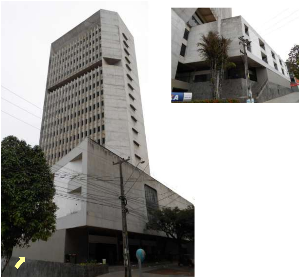
Figura 104 – Vista do edifício a partir da cota alta (imagem maior) e da cota baixa. Em ambas pode se ver um fechamento posterior entre o bloco em balanço e o arrimo de pedra (seta) Fonte – fotos do autor (2014)
