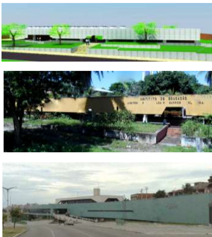
Figura 129 – No alto e centro, maquete eletrônica e situação atual do Pavilhão em abandono; em baixo, ângulo do IML de onde as reformas são pouco perceptíveis e a forma original permanece. Aberto ou fechado, os longos corpos de concreto se assemelham a caixas.
