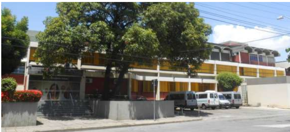
Figura 87 – No alto a fachada principal. No centro a fachada norte com empenas de concreto liso e corrugado. Em baixo, a fachada do poente, a mais homogenea de todas Fonte – Fotos do autor (2014)
