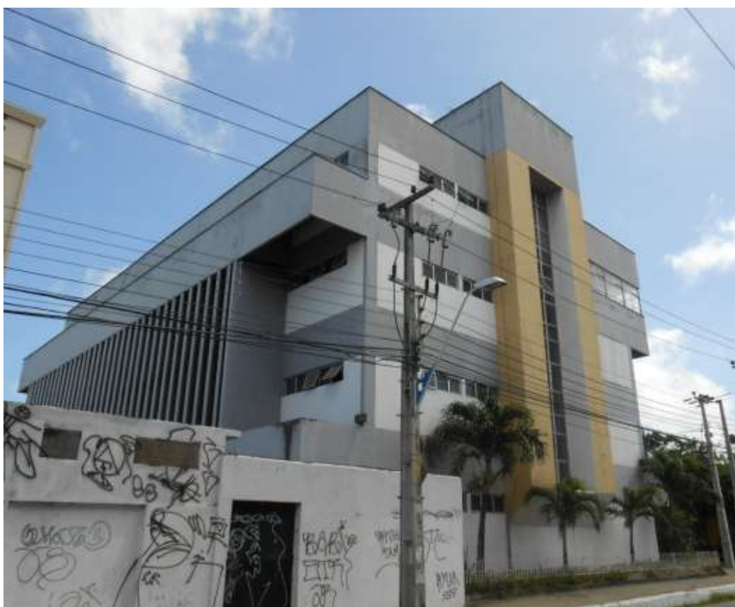
Figura 95 –Vista atuais onde se percebe que as fachadas principal e posterior são iguais. A caixa de escada se destaca na lateral, atravessada de cima a baixo por um janelão. Fonte – fotos do autor (2014)
