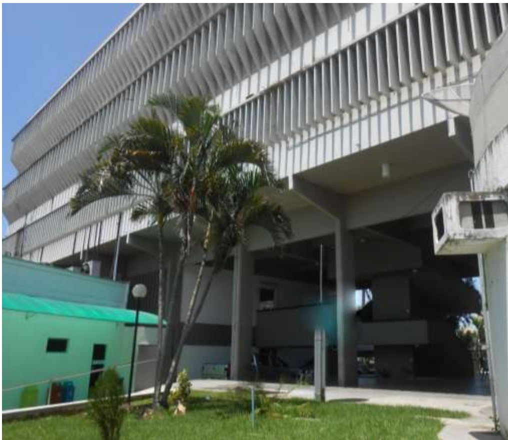
Figura 60 – Duas vistas atuais do Incri. Em cima, fachada principal e em baixo, fachada posterior onde se pode ver o vazio central com escada que unia as ruas e parte do volume da garagem, á esquerda. Fonte – Fotos do autor (2014)
