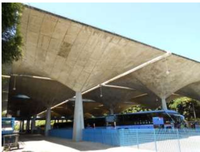
Figura 120 – Exemplos de engenharia e projeto locais onde o agigantamento das soluções estruturais se manifesta. Á esquerda, os grandes 'cogumelos' do terminal rodoviário ainda exibem as marcas dos compensados usados em suas formas num momento de despreocupação sustentável e á direita, na Sede do BNB, presença de enormes viga-marquise e empenas cegas, além da transferência de carga para pilar central. Fonte –Foto e croqui do autor (2014)
