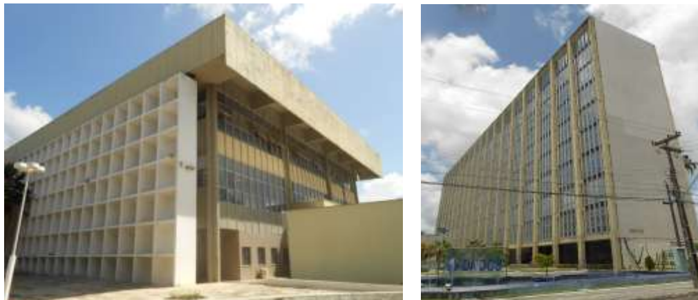
Figura 126 – À esquerda, Biblioteca Central o Pici, de Nercio Araújo, primeira metade dos anos 70. À direita, Sede do DNOCS, de Marcílio Dias da Luna, 1968-73 Fonte – Fotos do autor (2014)
