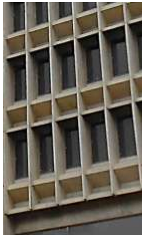
Figura 80 – Pré moldados que compõem os planos de esquadria (esq). Solene austeridade na entrada do prédio, conjunto quase abstrato de formas (dir).
