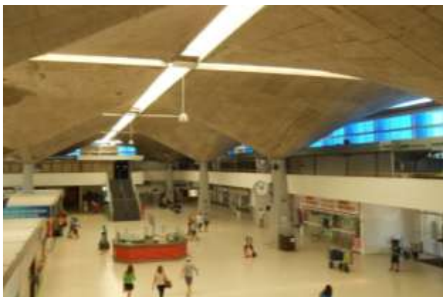
Figura 135 – A esquerda, no alto, a caixa que contém a área social da rodoviária, cuja aparência atual pode ser vista na foto de baixo, juntamente com o módulo espaço-estrutural. À direita, Escola de Música do Sesi. Fonte – Fotos do autor (2014) (esq) e Arquitetura no Brasil, anos 80, 1988
