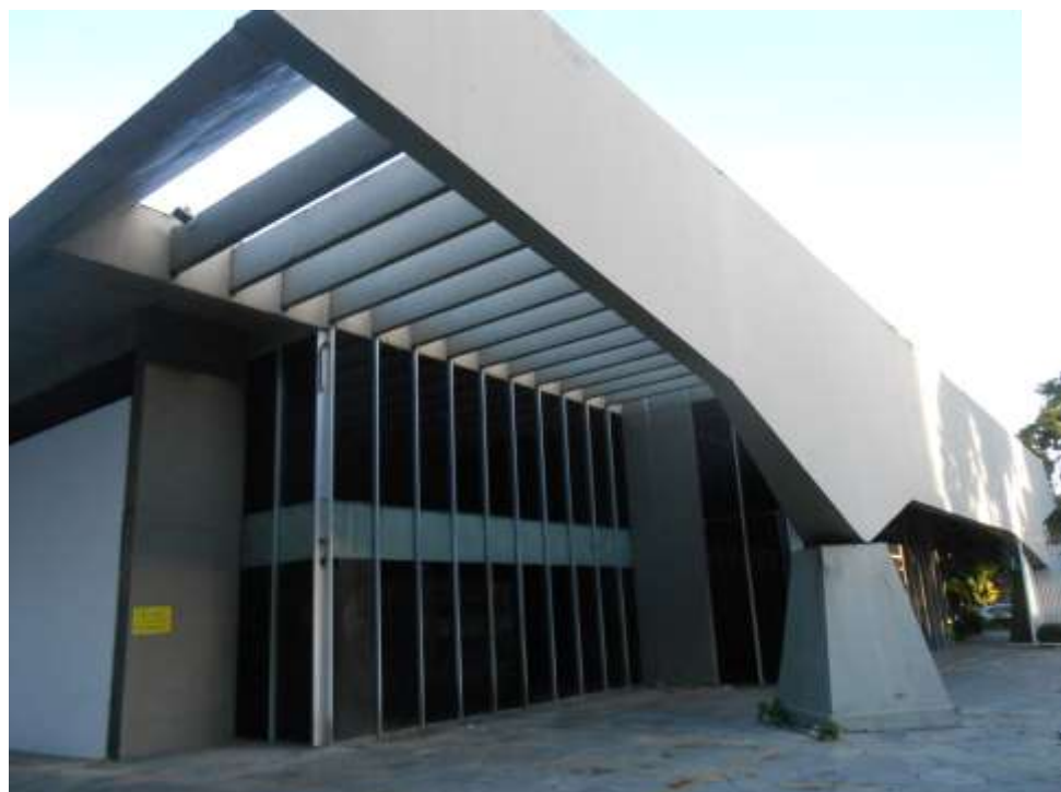
Figuras 114 – Vistas externas e detalhe da coberta Fonte – fotos do autor (2014)
