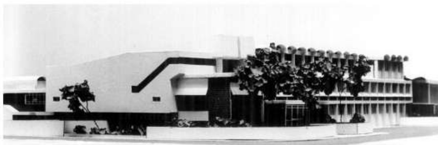
Figura 88 – Em cima, estruturas menores em concreto e variedade de tratamento das fachadas. Em baixo, foto da década de 80, assim como ainda hoje, pouco modificada. Em baixo, maquete Fonte – Fotos do autor (2014) (em cima) www.hemoce.ce.gov.br (centro) e DIÓGENES e PAIVA; 2011
