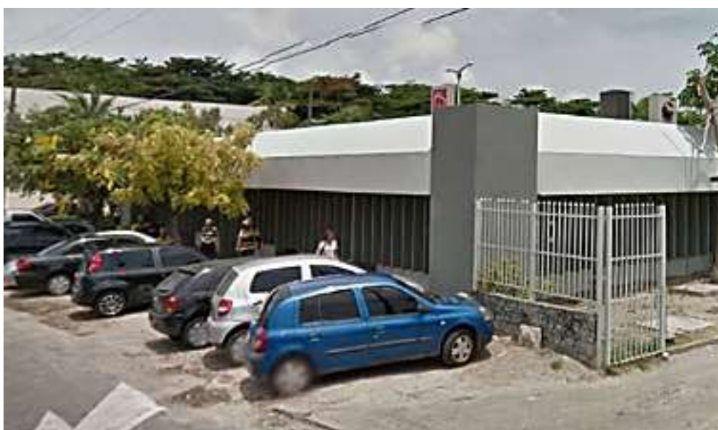
Figura 116 – Vistas do predio térreo
