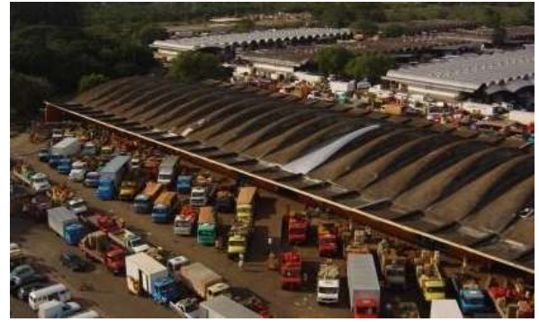
Figura 13 - O edifício do Conjunto Residencial da Universidade de São Paulo, 1962, (esq.); padronização e prefabricação na tentativa de incrementar o grau de industrialização da arquitetura brasileira. A central de Abastecimento de Porto Alegre, 1972, recorre a repetição de uma unidade espaço-estrutural, no caso, a abóbada autoportante em cerâmica armada de Eladio Dieste.
