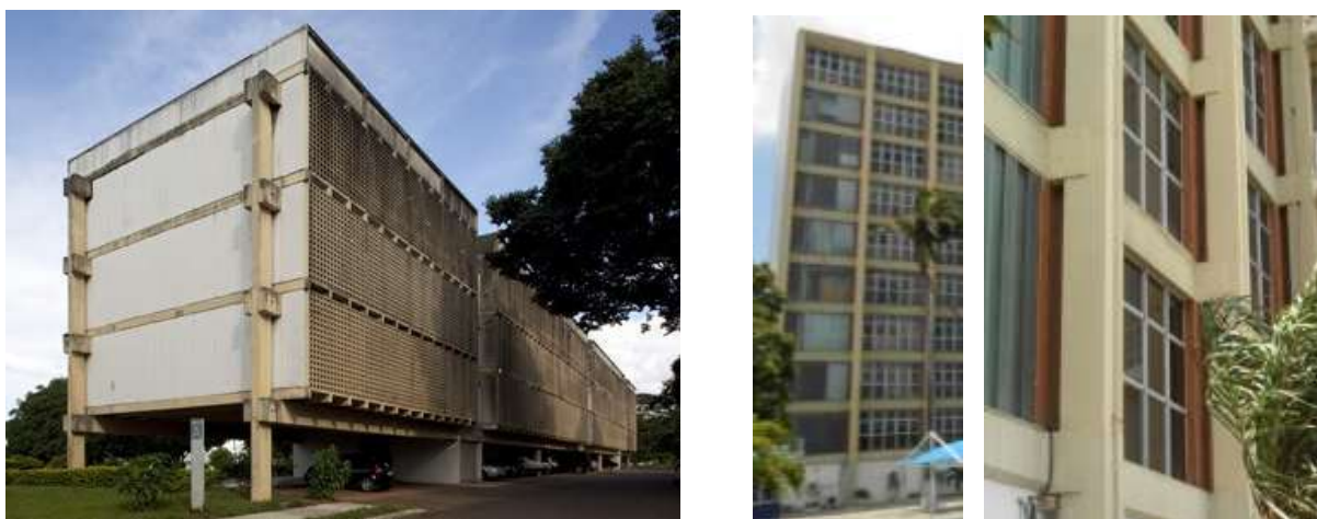
Figura 123 – A direita, o Alojamento da Colina exibe uma aparência que acabou por se transformar numa fórmula: exibir a estrutura por convencional que seja. Em alguns casos, como na Sede do DNOCS (direita), um detalhamento mais elaborado do encontro viga-pilar evita a mera aplicação da regra Fonte - http://leonardofinotti.blogspot.com.br (esq) e fotos do autor (2014)
