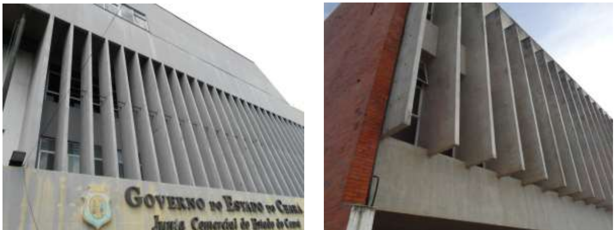
Figura 133 – À esquerda, Predio da Junta Comercial, 1985. À direita, brises da fachada principal da Biblioteca Pública, 1975..
