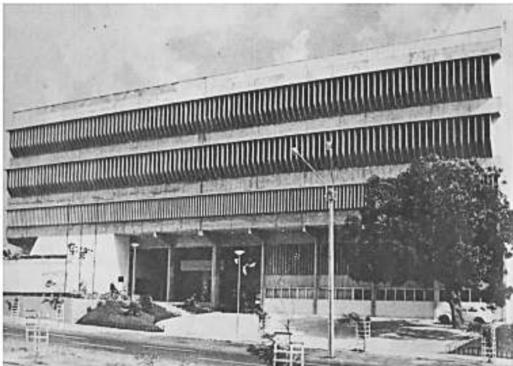
Figura 59 – No alto, vista da circulação interna e da vedação externa em pré-moldados de concreto. Em baixo, a foto antiga mostra a franqueza do acesso Fonte- http://www.ebah.com.br
