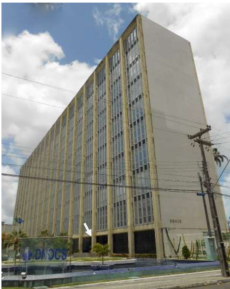
Figura 48 – O avanço da estrutura é mínimo, mal dá para configurar um exoesqueleto. Nessa fachada uma cor mais escura dos vidros indica as divisões dos pavimentos
