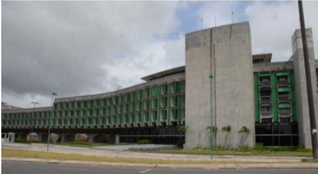
Fig. 15– João Filgueiras Lima elevou a racionalidade construtiva á um novo patamar pesquisando soluções originais e adequadas. As secretarias do novo centro administrativo de Salvador são construídas com grandes elementos pré-moldados, cujo desenho não descuidou da expressão estética.
