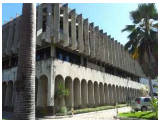
Figura 132 – À esquerda, brises e marquisades do INCRA cumprindo sua função por volta das 12:40h, horário em que a foto foi batida. À direita, o DENTEL, 1978, exhibe um desenho mais complexo e variado dos anteparos. Fonte – Fotos do autor
