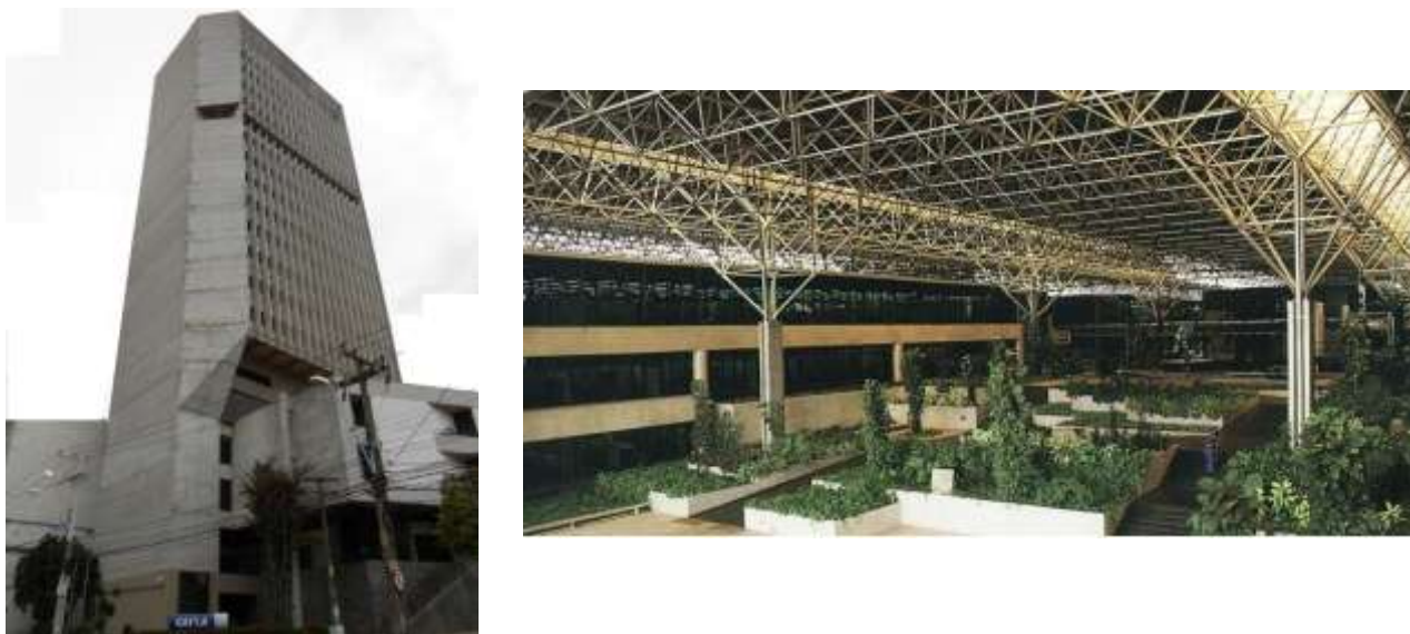
Figura 33 – O sólido e severo bloco da Sede da CEF, 1982-88, (esq), projeto de Carlos Pontual e Fernando Lima, é todo contraste com a imaterialidade das cobertas metálicas, imenso teto sem paredes para abrigar funções, como o Centro Administrativo do BNB, de Wesson Nóbrega e Marcos Mota, cuja 2ª etapa concluiu-se em 1985. Fontes – Foto do autor (2014) (esq) e http://acbarquitetura.blogspot.com.br (dir)
