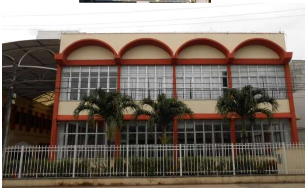
Figura 73 – No alto, os ‘sheds’ originais. No centro, vista superior mostrando a cobertura metálica e em baixo, aparência atual do Centro de Atendimento Social do SESC.
