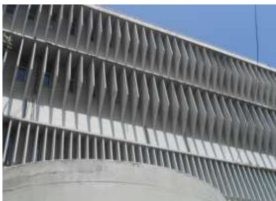
Figura 132 – À esquerda, brises e marquisades do INCRA cumprindo sua função por volta das 12:40h, horário em que a foto foi batida. À direita, o DENTEL, 1978, exhibe um desenho mais complexo e variado dos anteparos. Fonte – Fotos do autor
