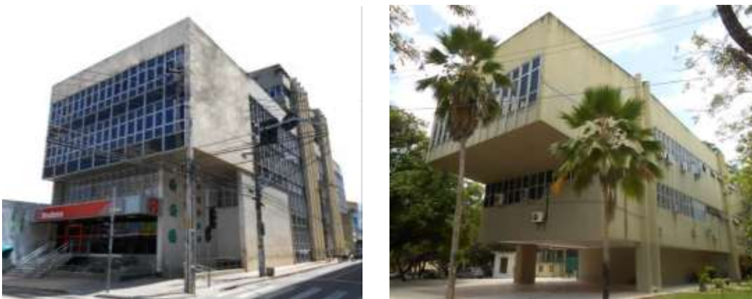
Figura 125 – À esquerda, Agencia Sede do BEC, Neudson Braga, 1968-70. À direita, Nucleo de Processamento de Dados do Pici, de Nearco Araújo, primeira metade da década de 70. Volumetria cúbica e planos de esquadrias como já se via em obras modernistas locais anteriores; mas a indecisão entre articular partes ou ser monovolume é nova.
