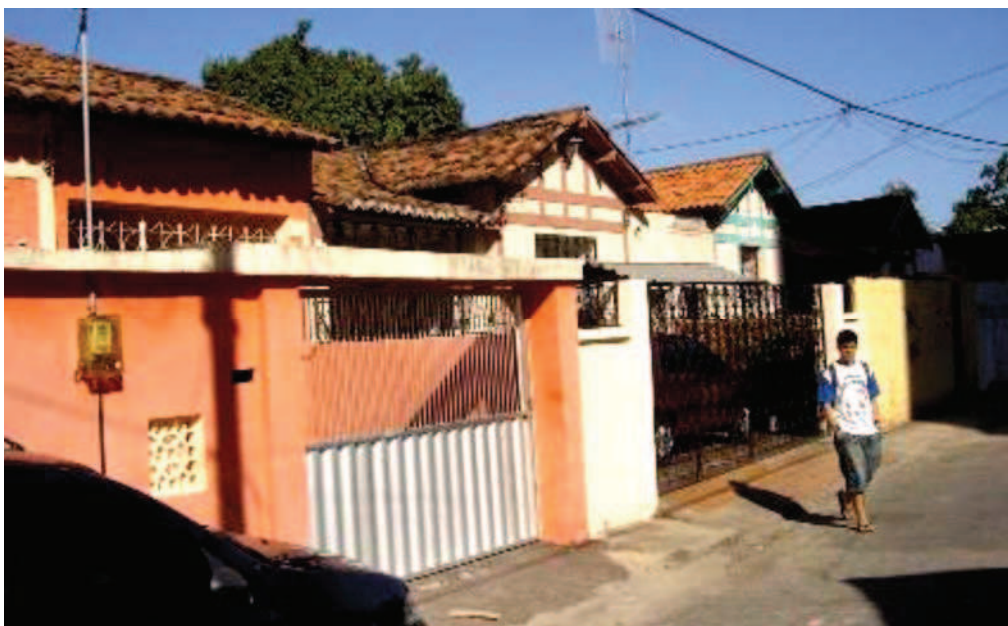
Figura 23 – Casas na antiga Vila Ferroviária de Otávio Bonfim, em Fortaleza (CE), ainda mantêm alguns traços originais.
