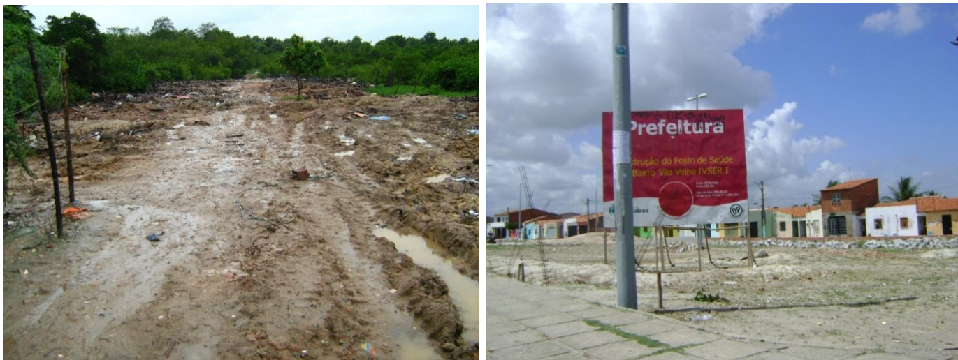
Figura 9: Obras sob responsabilidade do Orçamento Participativo – (A) antiga área ocupada pela comunidade do Buraco da Velha; (B) construção do Posto de Saúde. Fonte: SILVA (2008) e registro próprio (2009)
