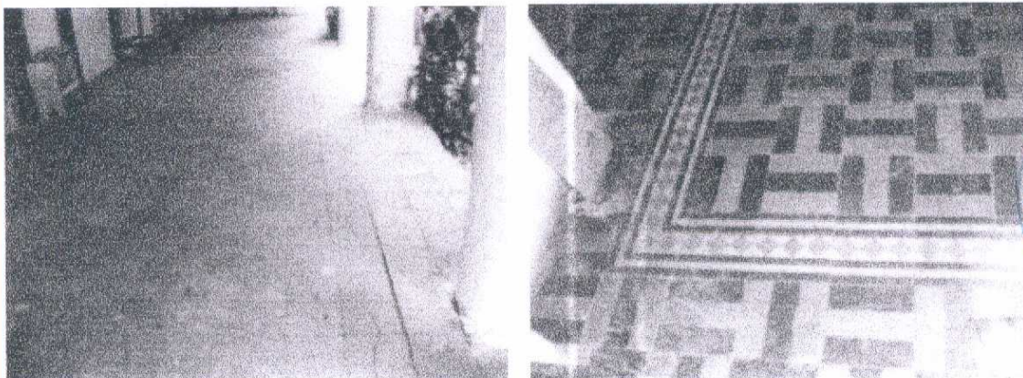
Piso usado na varanda e no interior da casa
