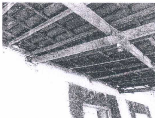
Telha marseilha (original) e telha colonial (instalada pelos novos moradores)
