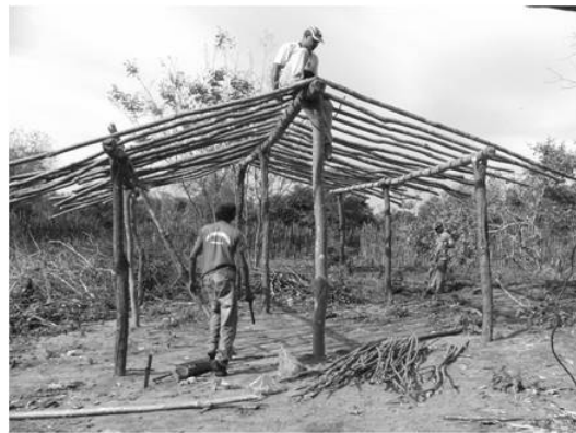
Construção da casa de Renato e Denise na aldeia Nazário
