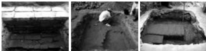
Figuras 08, 09, 10: tijolos cerâmicos em estruturas de contenção, pavimentação e alvenarias portantes (autor, 2009).
