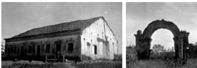
Figuras 5 e 6: Imagens do edifício conhecido como “Fazenda Belmonte”, em Saboeiro. Fonte: (Arquivo Central do Iphan-RJ).
