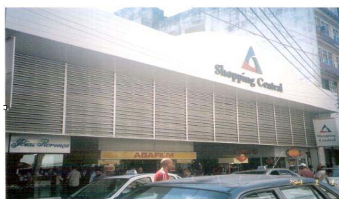
Figura 25: Fachada do Shopping Central Fonte: Freitas (2008)
