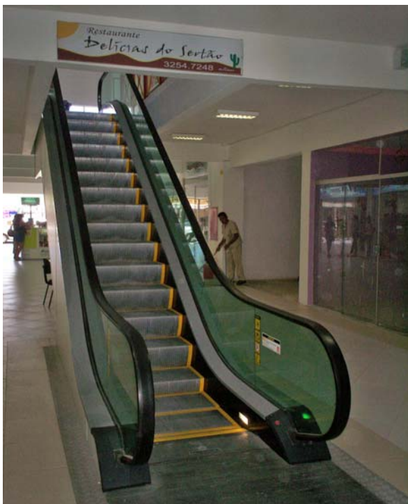
Figura 41: Escada rolante com sensor presencial Fonte: Freitas (2008)
