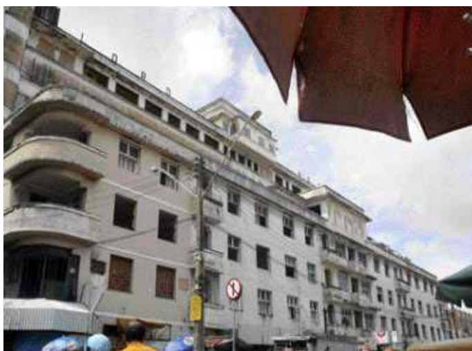
Figura 10: Fachada do extinto Lord Hotel – 2000. Fonte: Alcides Freire
