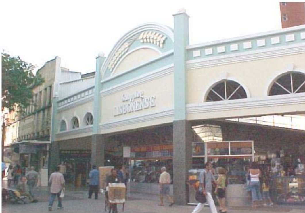
Figura 30: Shopping Lisbonense visto da Praça do Ferreira Fonte: Freitas (2008)
