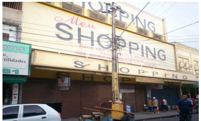
Figura 60: Meu Shopping fechado por incêndio no natal de 2007 Fonte: o autor (2007)
