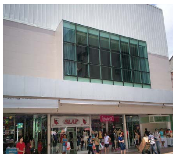
Figura 27: Fachada atual do Shopping Central Fonte: Freitas (abr / 2007)
