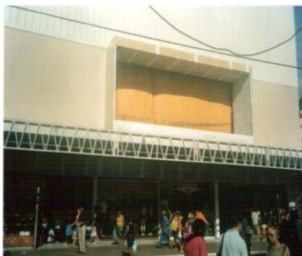
Figura 26: Shopping Central em reforma Fonte: Freitas (jan / 2007)
