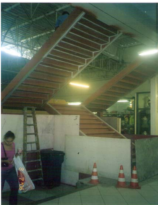
Figura 61: Escadaria em construção do Shopping Central – dezembro de 2006 Fonte: o autor (2006)
