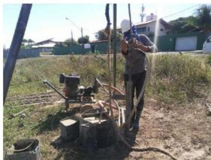
**Foto 03** - Detalhe da lavagem para atingir a cota de amostragem do furo.
