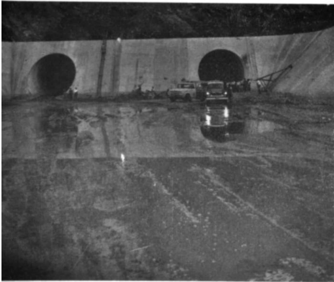
Canal de descarga - Barragem de Humaya
