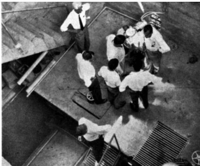
Barragem de Sanalona — Aparelhagem de manobra tomada d'água
