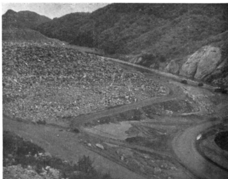
Caminho de serviço Barragem de Humaya
