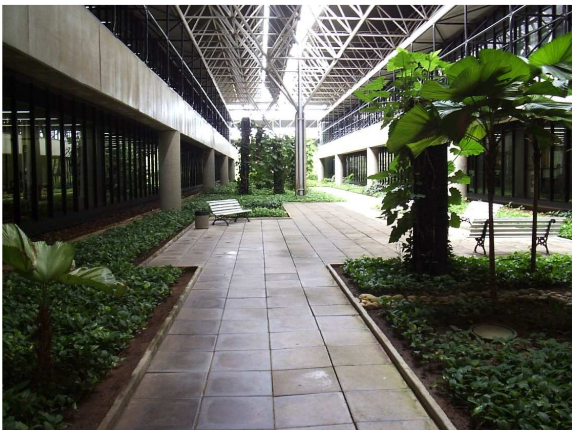
Figura 07 – Foto Jardins Blocos Centro Administrativo do BNB Fonte: Acervo do Autor
