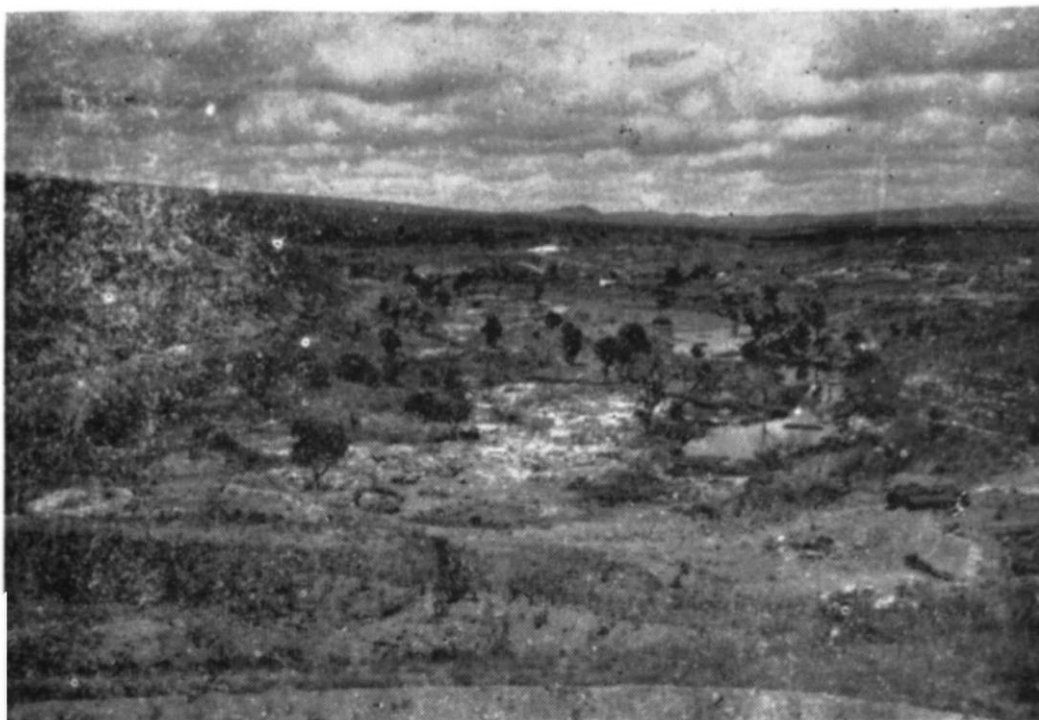
Foto 1 — Aspecto geral à jusante da barragem
