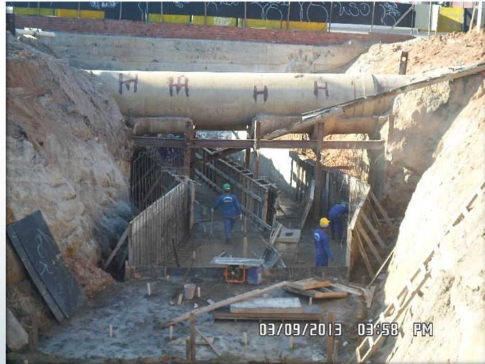
Execução de galeria no Canal do Desafio Jovem
