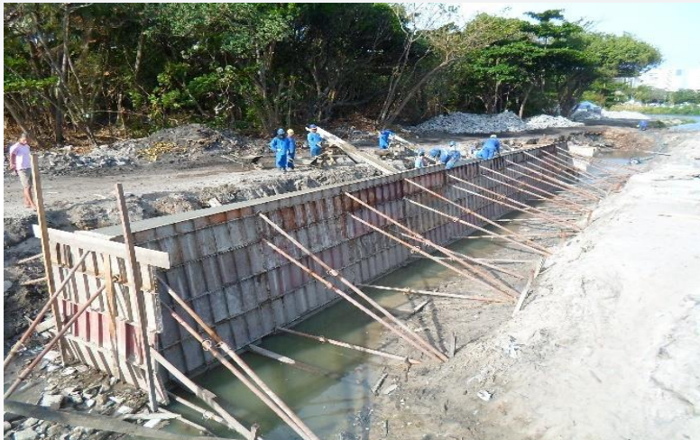
Canal Alagadiço (trecho da lagoa)
