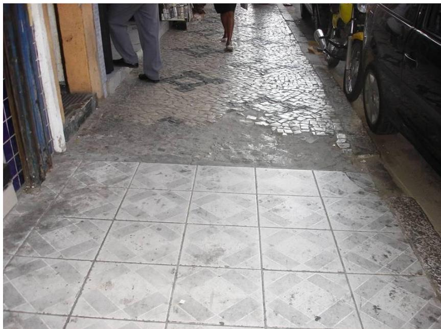
*Figura 3.13 – Pavimentação diversa em uma mesma calçada.*
