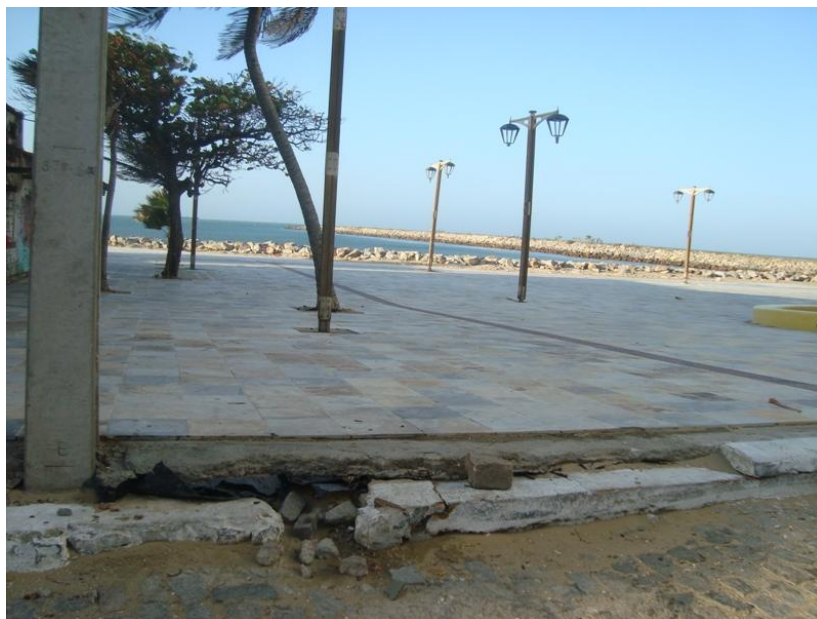
Figura 3.10 – Praia de Iracema após a obra de adequação das calçadas
