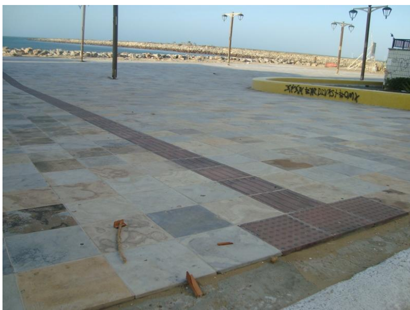
Figura 3.11 – Praia de Iracema após a obra de adequação das calçadas
