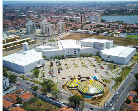
FIGURA 21 – SITUAÇÃO DEPOIS DA OUC JOQUEI CLUBE
