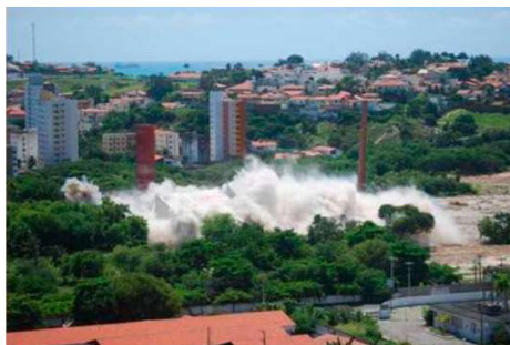
FIGURA 28 – SITUAÇÃO ANTES DA OUC – DEMOLIÇÃO ANTIGA FÁBRICA BRAHMA
