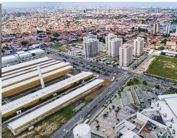
FIGURA 23 – SITUAÇÃO DEPOIS DA OUC JOQUEI CLUBE
