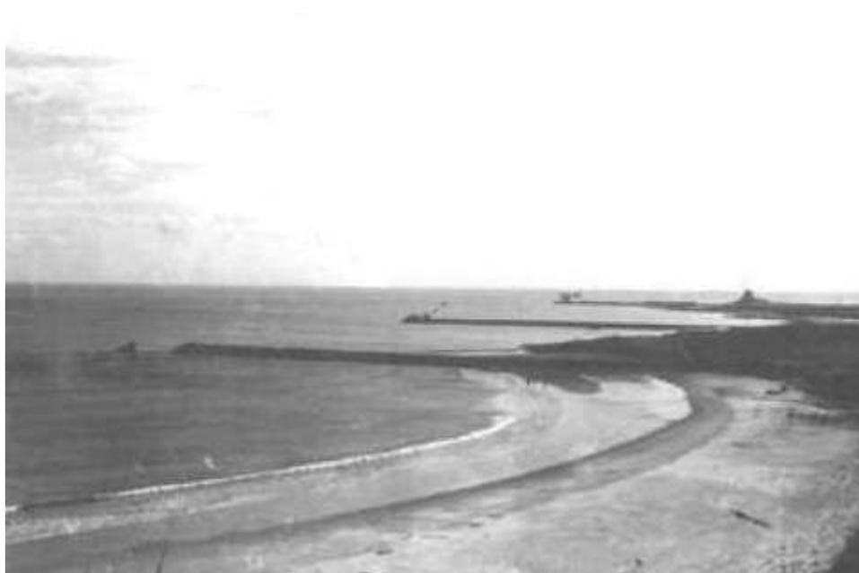
Figura 16: Foto da década de 1960 dos espigões construídos na faixa Leste/Oeste para tentar proteger o litoral das erosões provocadas após a instalação do porto do Mucuripe.
