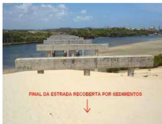
Figura 56: Estrada da ponte sobre o rio Cocó não mais visível por causa da invasão de sedimentos arenosos das dunas de Sabiaguaba.
