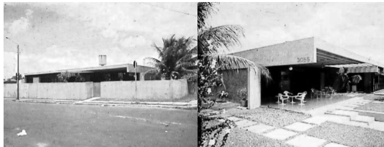
Figura 02 - Residência Jean Ary (1970) Fonte: Acervo Pessoal do Arquitetos
