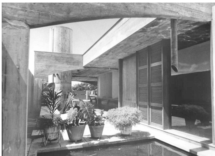
Figura 09 - Residência Raul Fontenele (1977?) Fonte: Acervo Pessoal do Arquitetos
