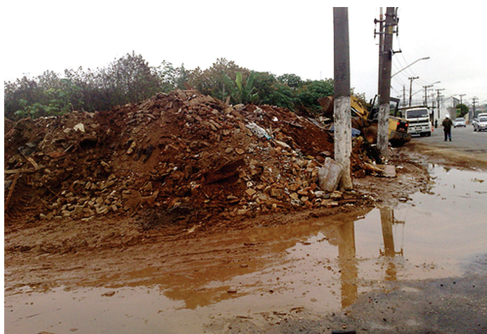
Figura 2 – Descarte irregular de resíduos de construção
