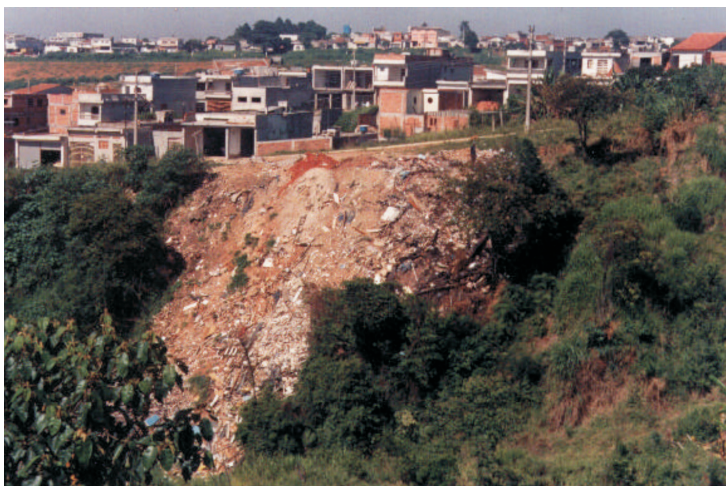
Figura 3 – Descarte irregular de resíduos de construção
