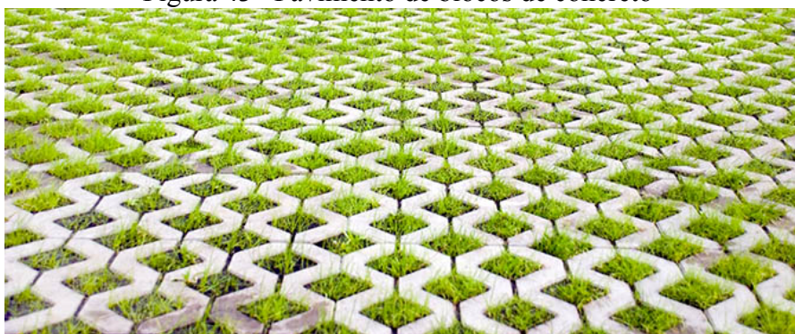
Figura 43– Pavimento de blocos de concreto
