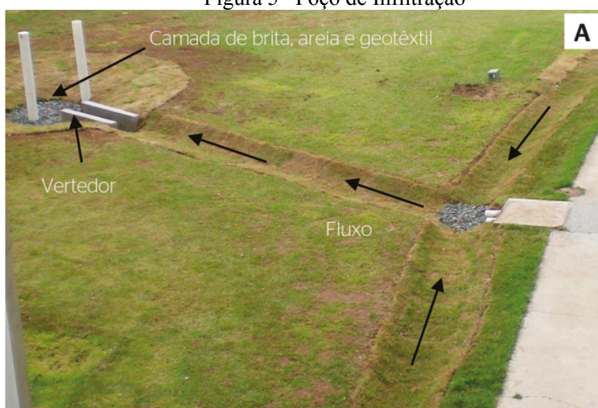
Figura 5– Poço de Infiltração
