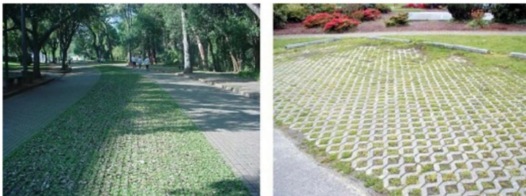
Figura 7 – Pavimento permeável
