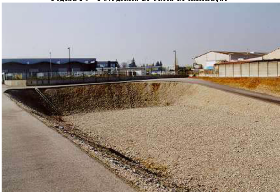
Figura 30 - Fotografia de bacia de infiltração
