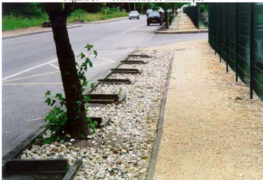
Figura 39 – Trincheira de infiltração
