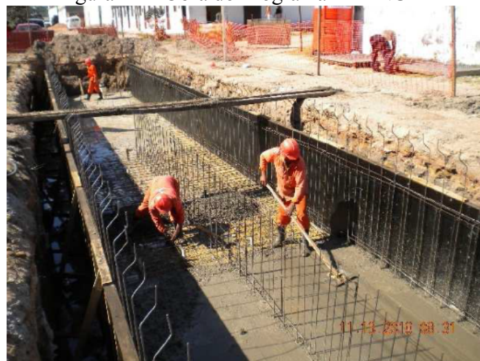
Figura 14 – Obra do Programa DRENURB
