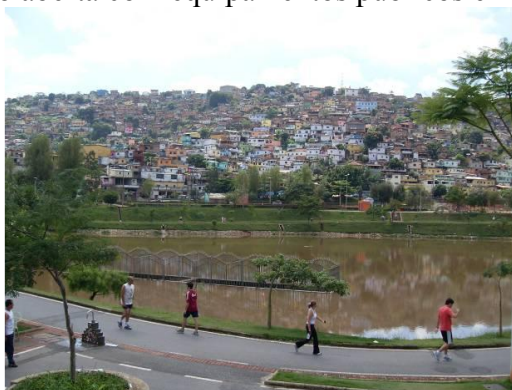
Figura 9 - Bacia de retenção aberta com equipamentos públicos em Belo Horizonte-MG
