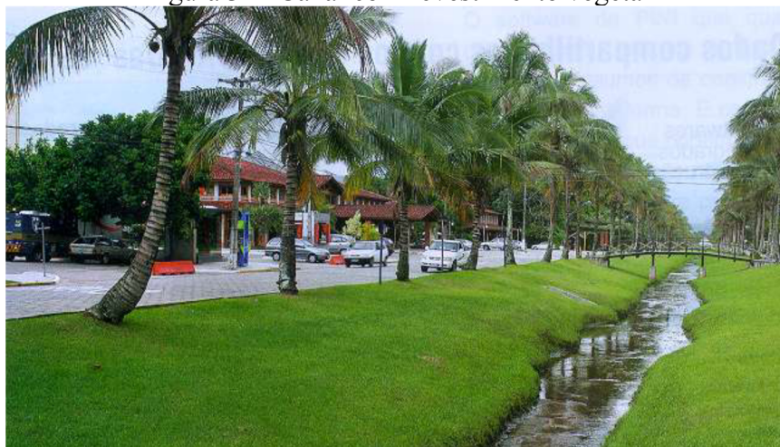
Figura 31– Canal com revestimento vegetal
