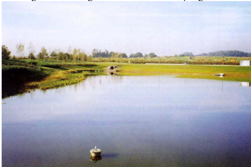
Figura 25 - Fotografia de bacia de retenção gramada
