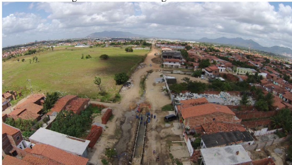
Figura 15 – Obra do Programa DRENURB
