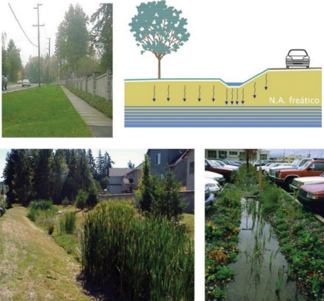
Figura 4 – Exemplos de valas de infiltração
