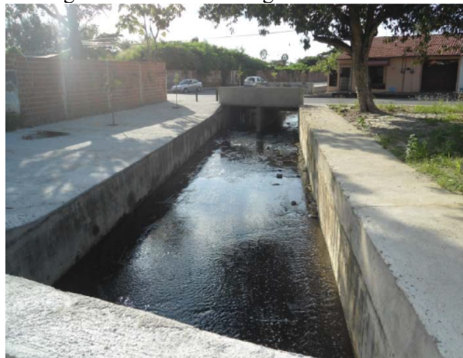
Figura 13 – Obra do Programa DRENURB
