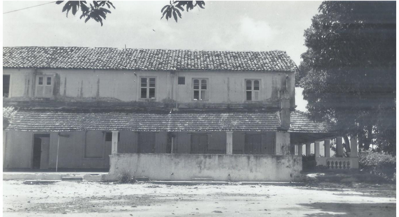
Imagem 2 - Edifício antigo do Colégio Santa Cecília demolido em 1965 e onde funcionou a Escola de Arquitetura e Urbanismo Fonte: Coleção da Biblioteca do Curso de Arquitetura e Urbanismo.
