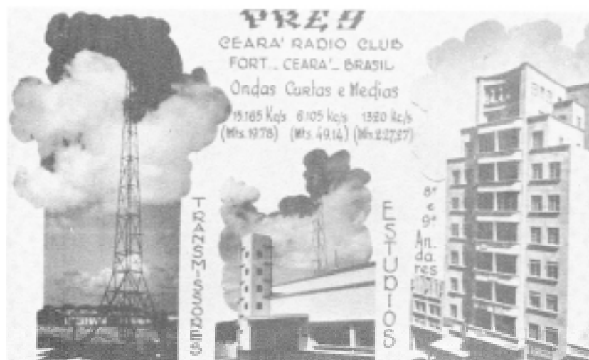
Cartão postal, produzido pela Aba Film, para a correspondência com ouvintes do exterior, vendo-se, da esquerda para a direita, a antena da emissora; o edifício de seus novos estúdios (em 1937), em São João do Tauape (onde funciona o Hipermercado Romcy e o Edifício Diogo, onde se situava os estúdios, nos 8º e 9º andares (Av. Barão do Rio Branco).
