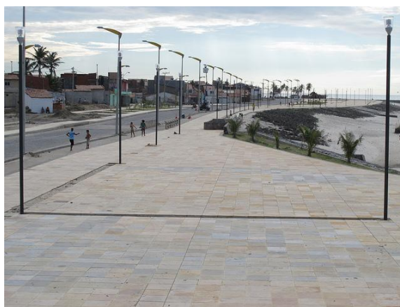
Figura 3: Trecho do calçadão já construído na orla Oeste de Fortaleza, parte do projeto "Vila do Mar" Fonte: http://goo.gl/4oZgt5 . Acesso em: 1 jun. 2015.
