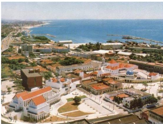
Figura 4: O equipamento "Dragão do Mar", no contexto da Praia de Iracema Fonte: http://goo.gl/Qhfmv . Acesso em: 1 jul. 2015.
