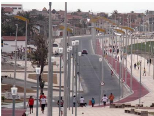
Figura 208: Via paisagística (passeio, faixa de automóveis, ciclovia e calçada), projeto Vila do Mar
