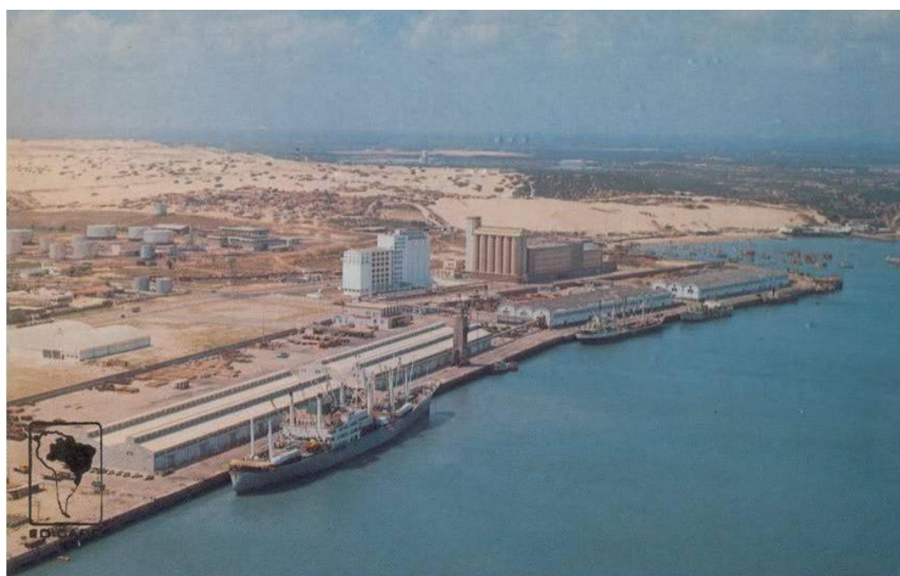
Figura 131: Porto do Mucuripe, nos anos 1960 Fonte: Postal Edicard, disponível em: http://goo.gl/obaMZ2 . Acesso em: 19 mar. 2013.
