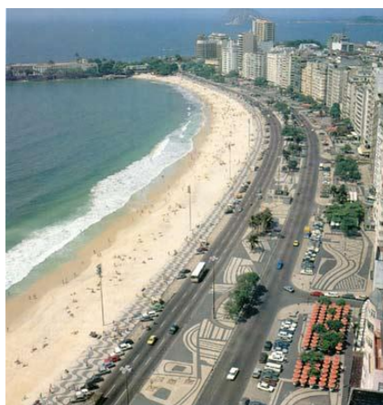
Figura 172: Calçadão da Praia de Copacabana, Rio de Janeiro-RJ: larguras fixas e paginação de piso com curvas Fonte: http://goo.gl/atmq3Y . Acesso em: 2 abr. 2014
