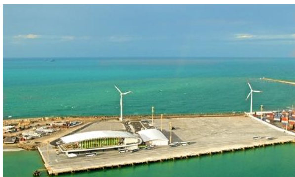
Figura 9: Vista do terminal marítimo de passageiros, inaugurado em 2014
