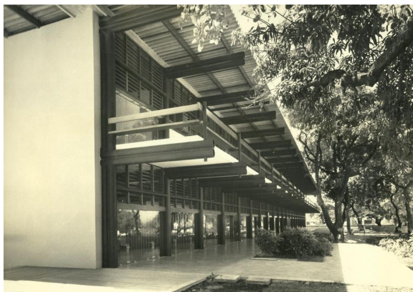
Figura 155: Detalhes construtivos do Palácio da Abolição: vigas e pilares metálicos em tubo e estrutura pavilionar
