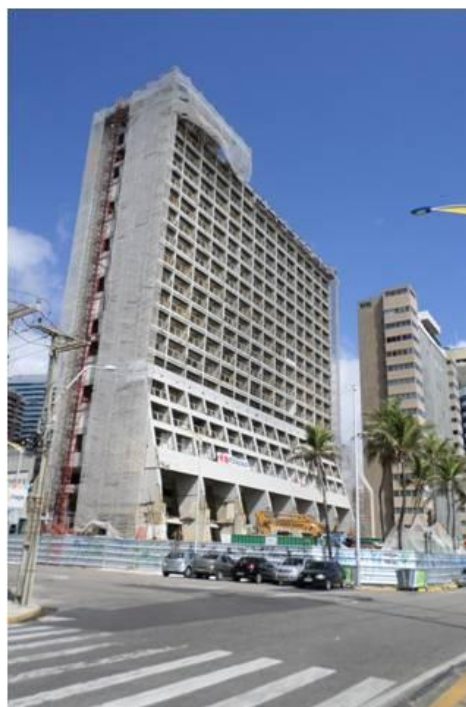
Figura 19: Hotel Esplanada, um dos primeiros hotéis da orla da Avenida Beira-Mar em processo de demolição, recentemente
