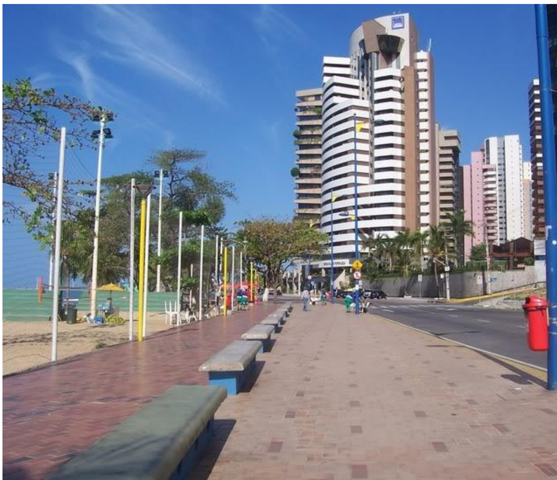
Figura 196: Calçadão da Avenida Beira-Mar, após as obras do Projeto Orla Marítima, em frente ao GranVille. Fonte: http://www.skyscrapercity.com/showthread.php?t=562355 . Acesso em: 8 mar. 2015
