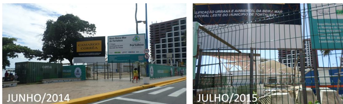
Figura 217: Mercado dos Peixes em construção, em junho de 2014 e julho de 2015, com a cobertura quase pronta. Fonte: nosso acervo.
