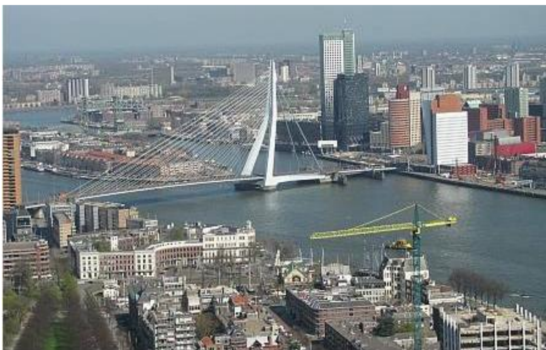
Figura 53: A Ponte Erasmus, ligando a zona Norte (à esquerda) e a zona Sul, à direita Fonte: http://goo.gl/2GVwRP . Acesso em: 14 mar. 2014.
