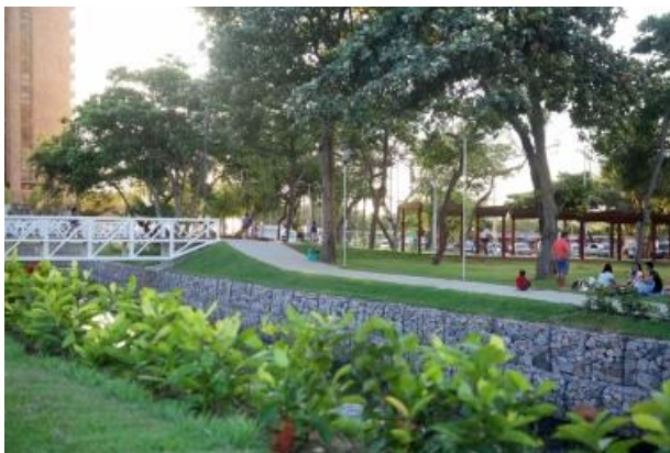
Figura 229: Trecho urbanizado do Parque Foz do Riacho Maceió
