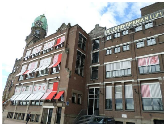
Figura 55: Fachada do Hotel New York, existente antes do projeto Kop van Zuid Fonte: acervo nosso.
