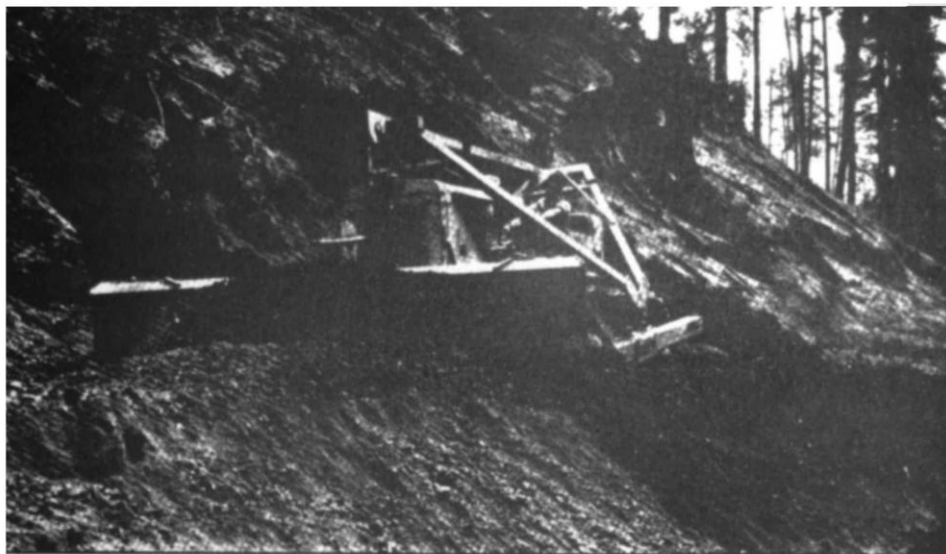
UMA ANGLEDOSER EXECUTANDO O "TRABALHO PIONEIRO" EM UMA ENCOSTA INGREME E COBERTA DE FLORESTA
