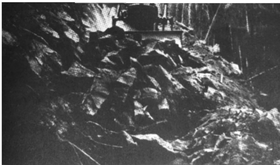
ROAD-BUILDER REMOVENDO MATERIAL DYNAMITADO EM ENCOSTA INGREME
