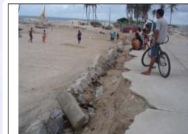
Fotografia 5 - Trecho da Avenida Costa Oeste em processo de degradação por ter sido instalado em área de domínio das marés e em uma faixa de praia submetida a processo erosivo acelerado (Fonte: Projeto Orla, fevereiro de 2006).
