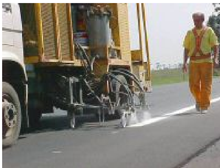
Figura 3.2: pintura mecanizada
