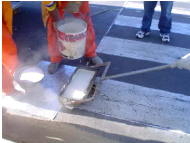
Figura 3.3: pintura com termoplástico estrudado
