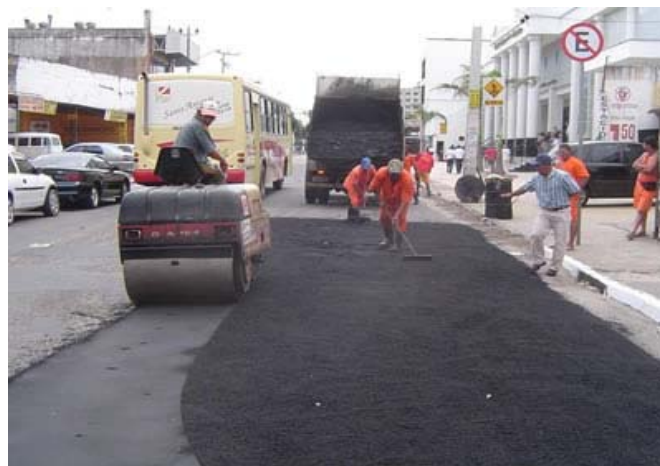
Figura 4.1: Recapeamento em vias de Fortaleza
