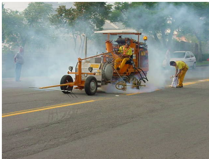
Figura 3.4: pintura com termoplástico hot spray
