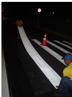
Figura 3.5: aplicação do laminado pré-fabricado
