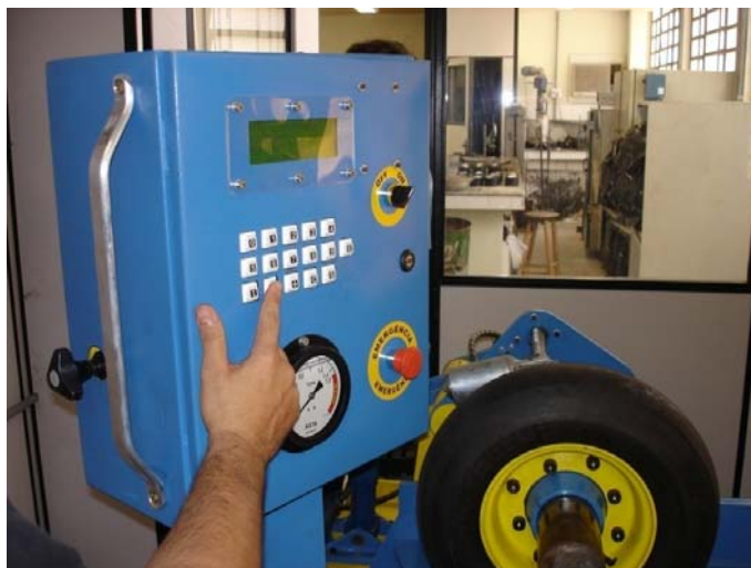
Figura 3.14: Painel eletro-eletrônico do compactador do LMP
