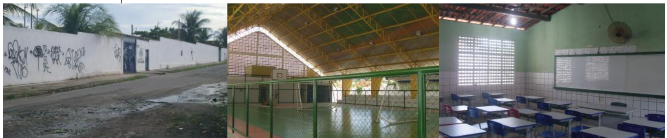
Fachada externa; quadra poliesportiva e sala de aula. Fotos: Ellen Garcia
