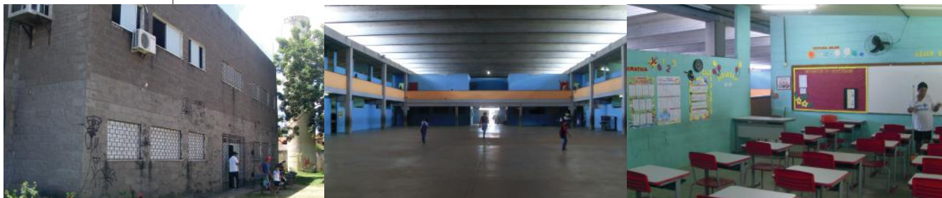
Fachada externa; pátio interno e sala de aula. Fotos: Ellen Garcia
